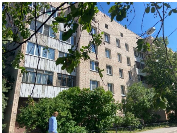
Фото 2. Вид здания, в котором расположен Объект оценки
