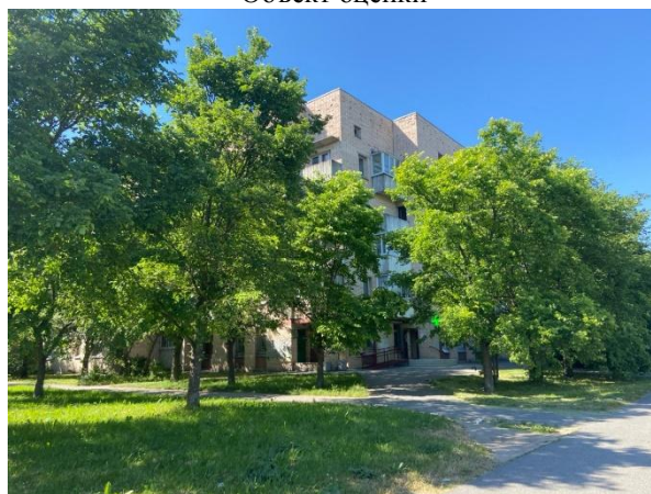
Фото 10. Вид здания, в котором расположен Объект оценки
