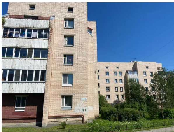
Фото 7. Вид здания, в котором расположен Объект оценки
