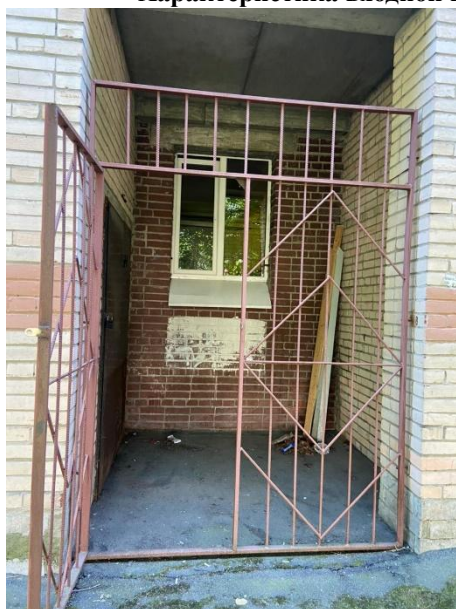
Фото 11. Отдельный вход с улицы
