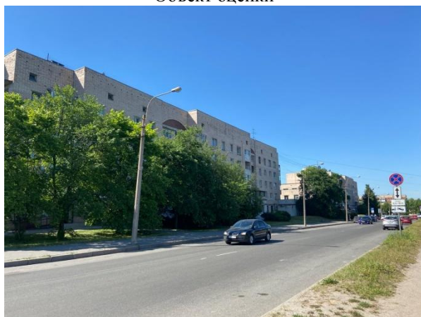
Фото 9. Вид здания, в котором расположен Объект оценки, ближайшее окружение
