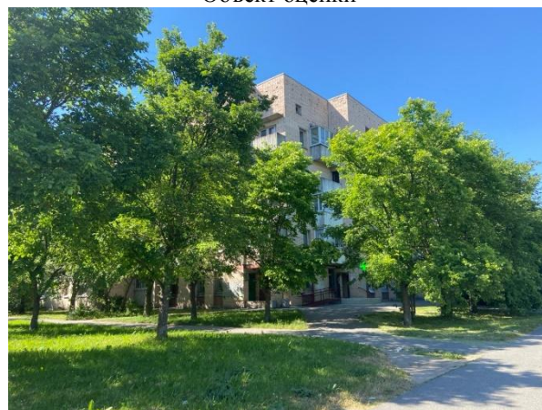
Фото 10. Вид здания, в котором расположен Объект оценки
