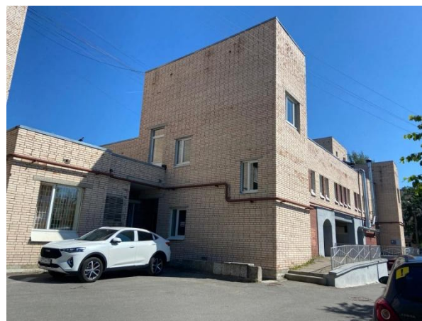
Фото 8. Вид здания, в котором расположен Объект оценки
