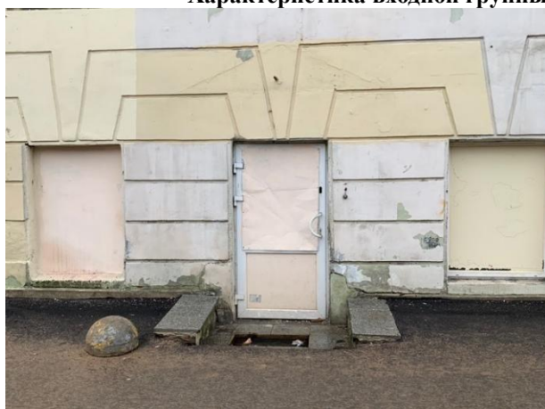
Фото 7. Отдельный вход с улицы
