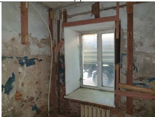
Фото № 19 – Внутреннее состояние
