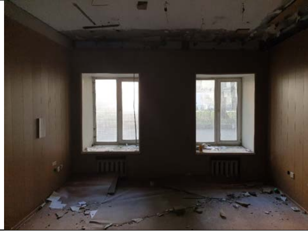
Фото № 7 – Внутреннее состояние
