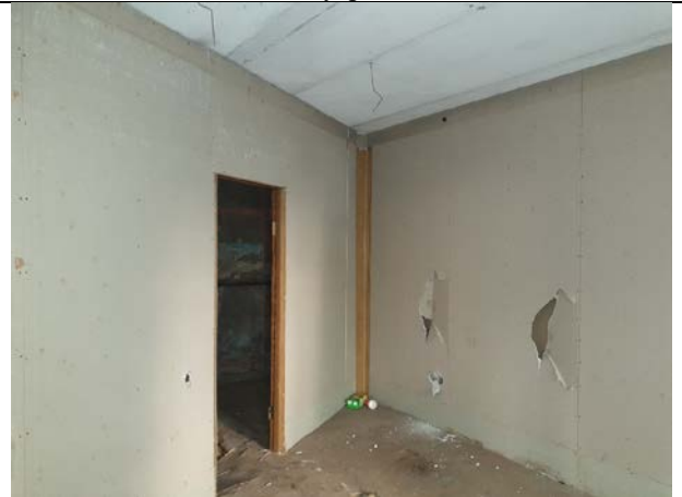
Фото № 24 - Внутренне состояние
