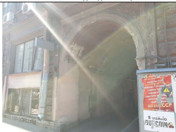
Фото № 33 – Фасад здания (со стороны улицы)
