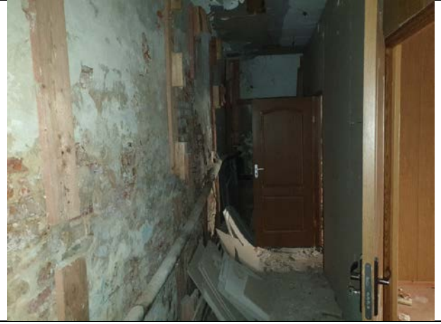
Фото № 6 - Внутренне состояние
