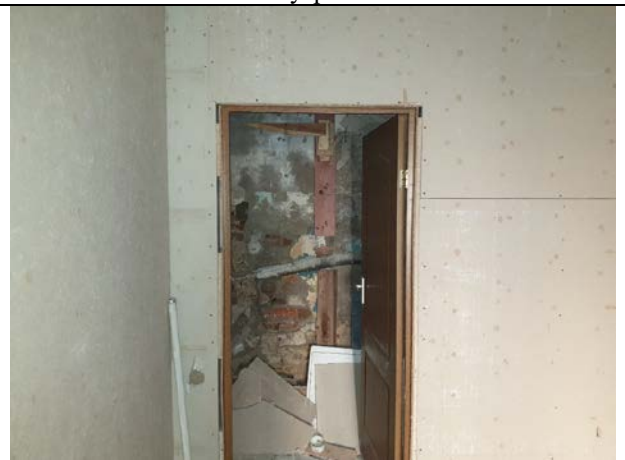
Фото № 10 - Внутренне состояние
