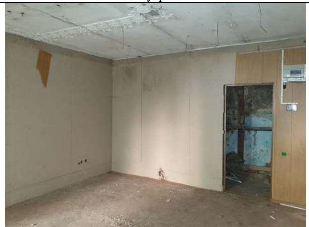
Фото № 18 - Внутренне состояние
