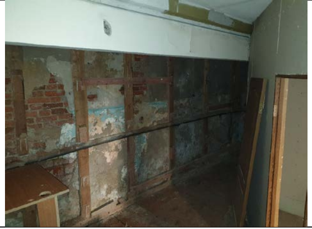
Фото № 22 - Внутренне состояние
