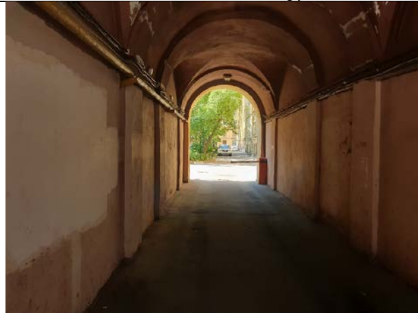
Фото № 31 – Подъезд в помещении
