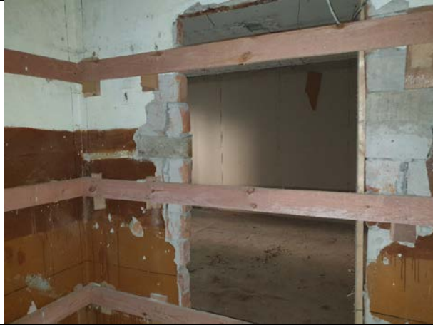
Фото № 13 – Внутреннее состояние
