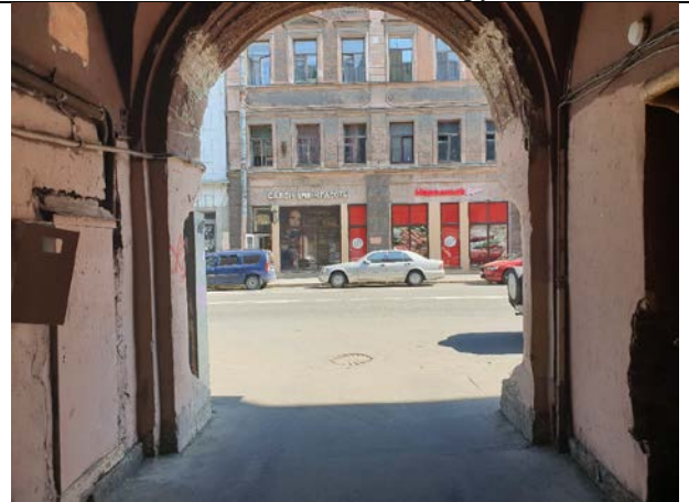
Фото № 32 – Подъезд в помещении
