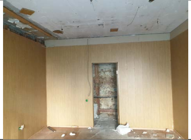
Фото № 8 - Внутренне состояние
