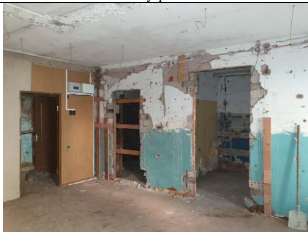
Фото № 17 – Внутреннее состояние
