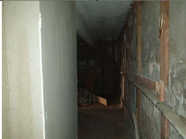
Фото № 15 – Внутреннее состояние
