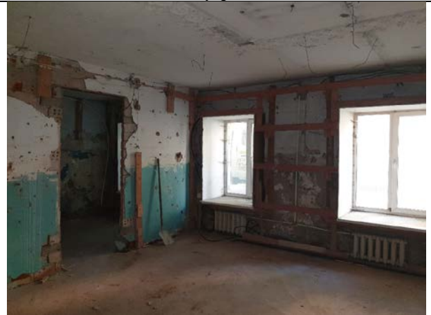
Фото № 16 - Внутренне состояние
