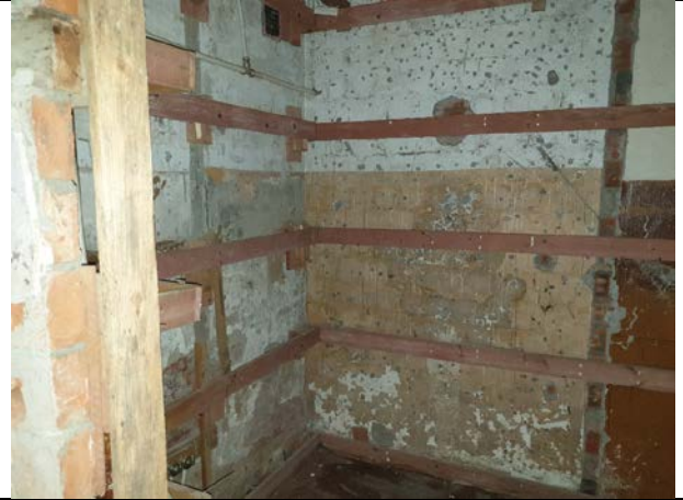
Фото № 14 - Внутренне состояние
