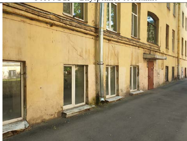
Фото № 27 - Фасад здания (внутри двора)
