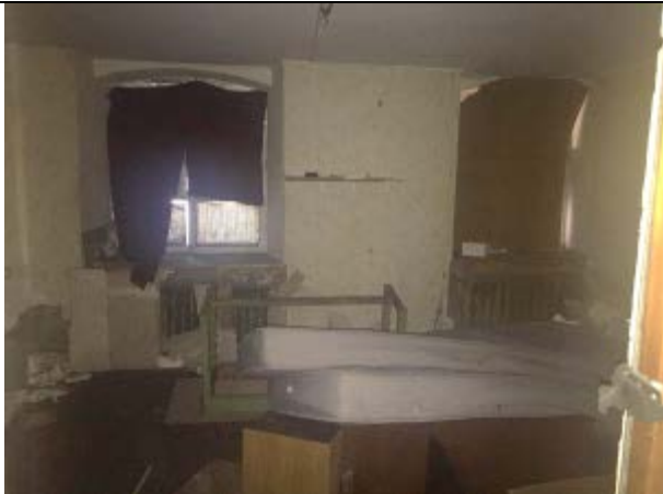
Фото 21. Типичное состояние Объекта оценки
