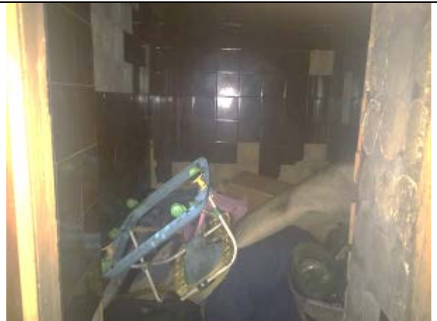
Фото 16. Типичное состояние Объекта оценки
