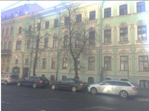
Фото 7. Вид здания расположения Объекта оценки
