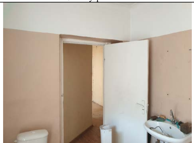
Фото № 8 – Внутреннее состояние
