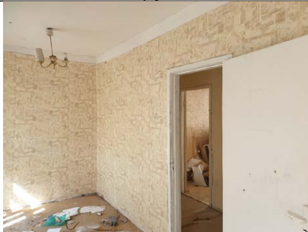
Фото № 5 – Внутреннее состояние
