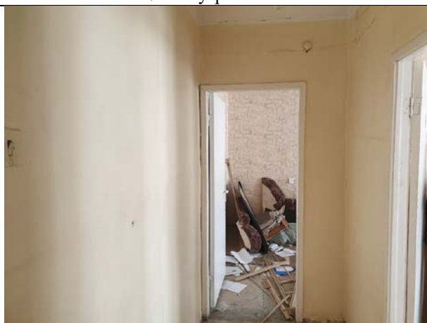
Фото № 9 – Внутреннее состояние
