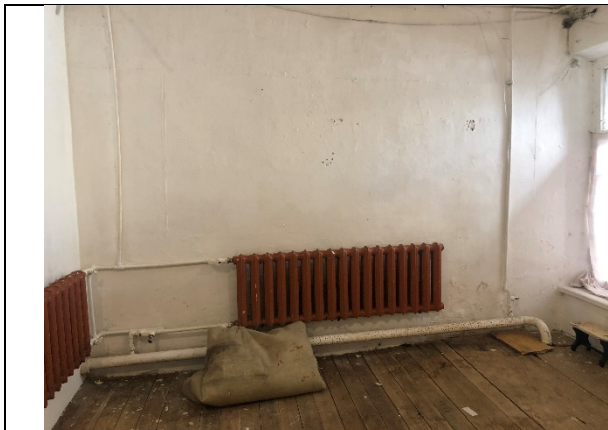
Фото № 7 - Внутренне состояние
