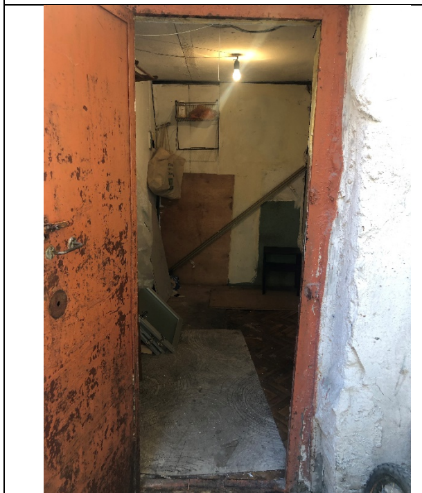
Фото № 3 – Внутреннее состояние
