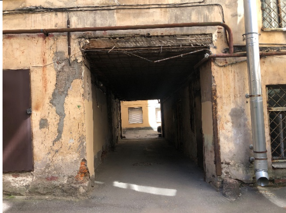
Фото № 15 - Проход к помещению
