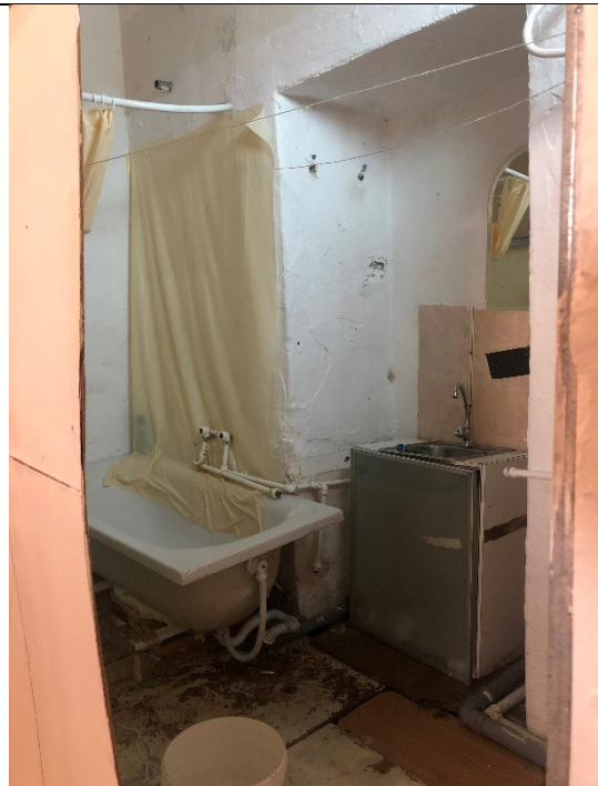
Фото № 10 - Внутренне состояние
