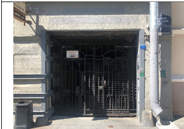
Фото № 11 – Проход к помещению
