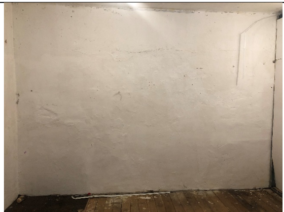
Фото № 8 - Внутренне состояние
