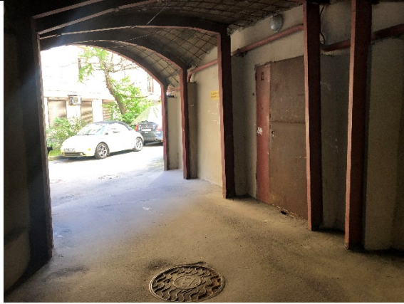
Фото № 13 - Проход к помещению
