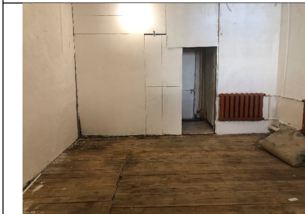
Фото № 5 – Внутреннее состояние
