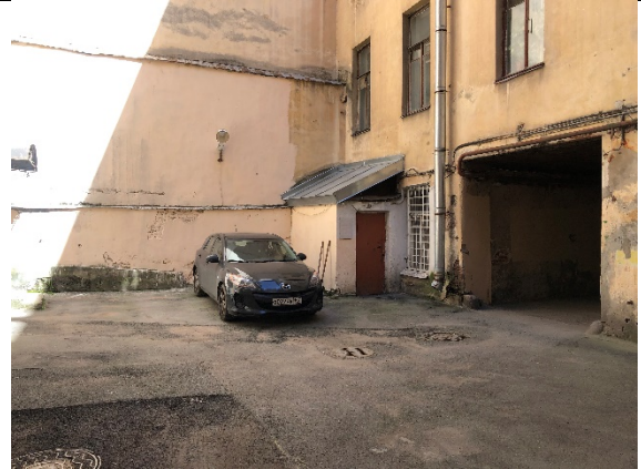
Фото № 16 - Проход к помещению
