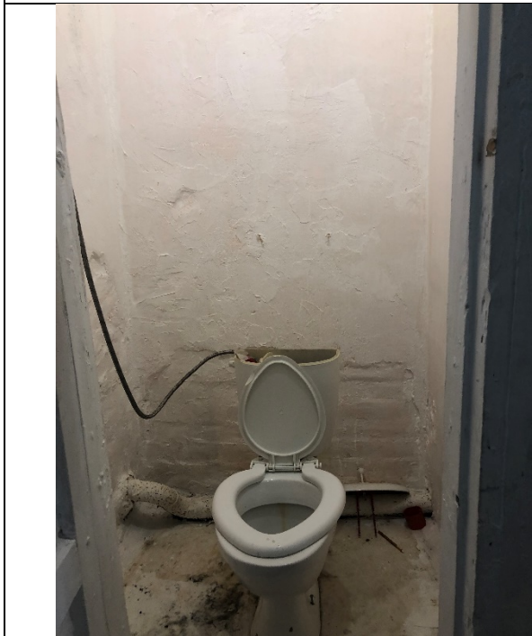
Фото № 9 - Внутренне состояние
