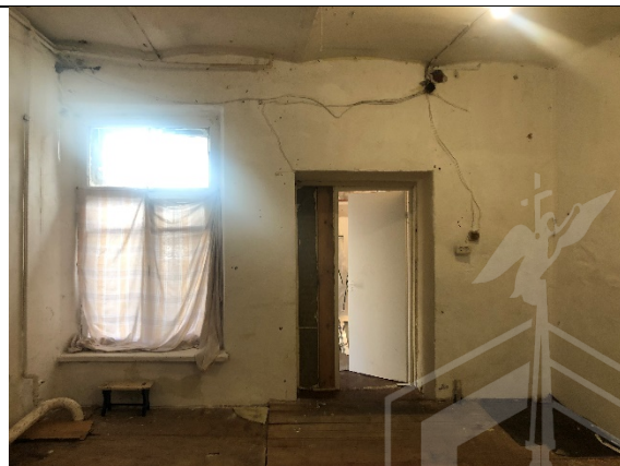
Фото № 6 - Внутренне состояние
