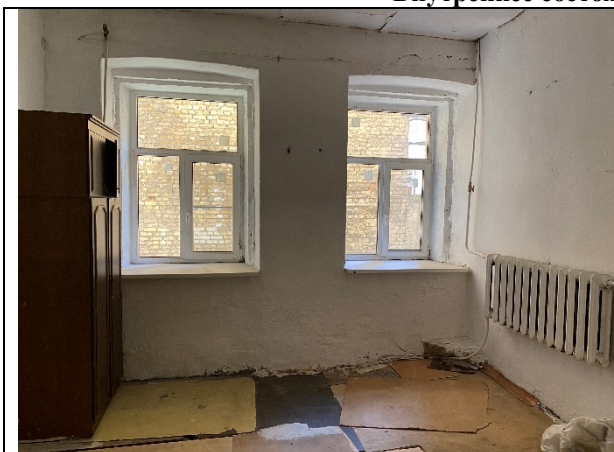
Фото 15. Внутреннее состояние Объекта оценки
