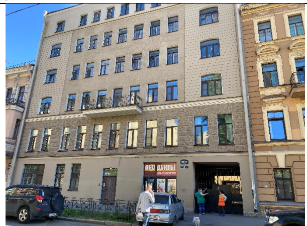
Фото 2. Вид здания, в котором расположен Объект оценки, с улицы
