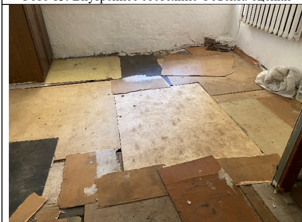
Фото 17. Внутреннее состояние Объекта оценки
