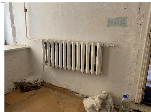
Фото 19. Внутреннее состояние Объекта оценки
