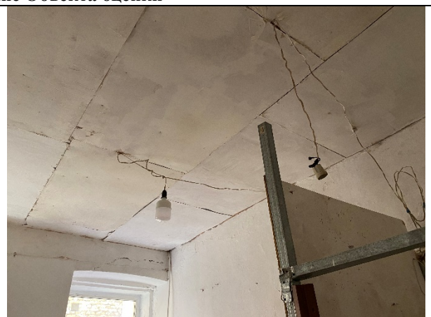
Фото 16. Внутреннее состояние Объекта оценки
