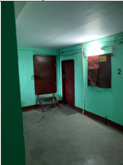
Фото №11 Проход к помещению 5-Н
