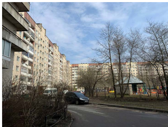
Фото №5 Жилой дом, в котором располагается Объект оценки
