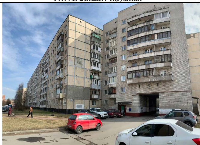
Фото №3 Жилой дом, в котором располагается Объект оценки
