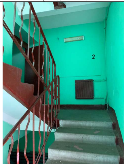
Фото №10 Проход к помещению 5-Н
