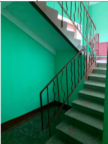
Фото №9 Проход к помещению 5-Н
