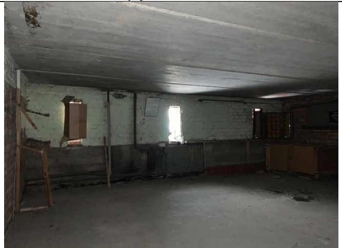
Фото №16. Внутреннее состояние пом. 5-Н
