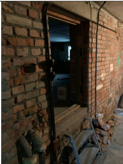
Фото №13 Внутреннее состояние пом. 5-Н
