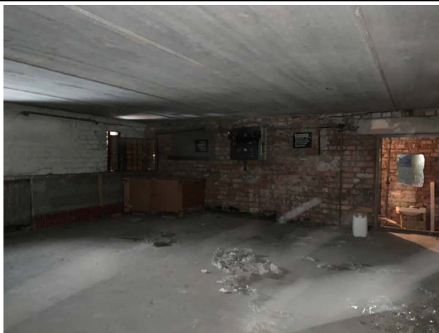
Фото №17 Внутреннее состояние пом. 5-Н
