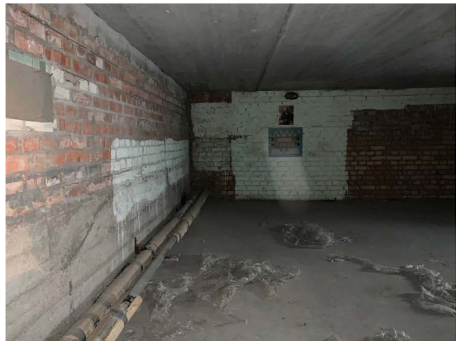
Фото №14 Внутреннее состояние пом. 5-Н
