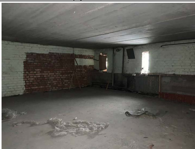
Фото №15. Внутреннее состояние пом. 5-Н
