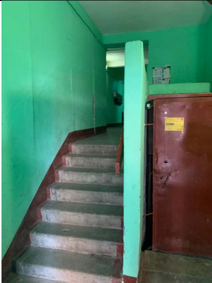
Фото №7 Проход к помещению 5-Н
