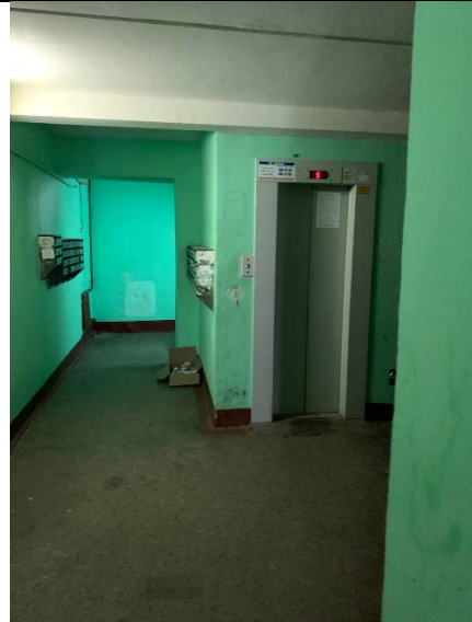
Фото №8 Проход к помещению 5-Н
