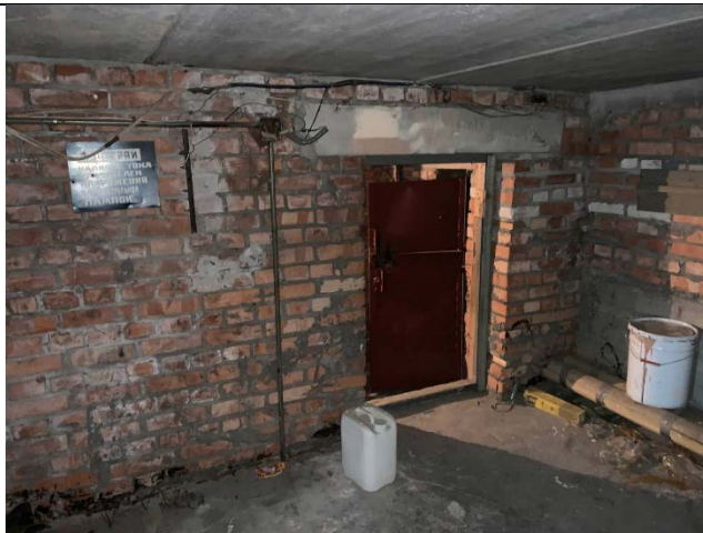
Фото №19 Внутреннее состояние пом. 5-Н
