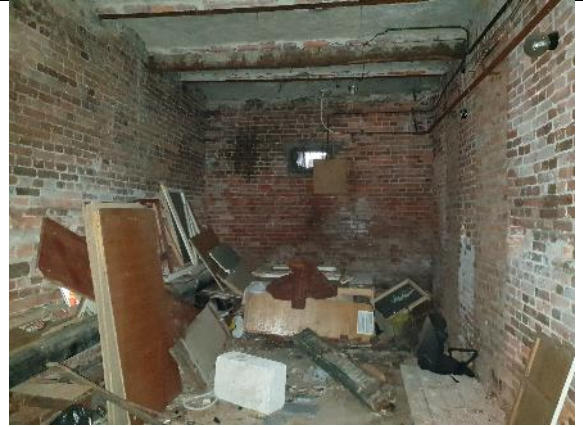
Фото №10: Внутренняя отделка помещения
