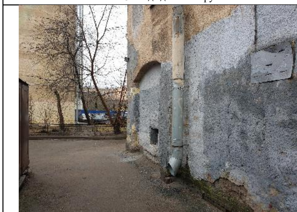
Фото №5: Вид здания снаружи
