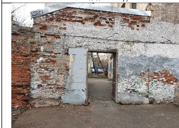
Фото №7: Вид здания снаружи
