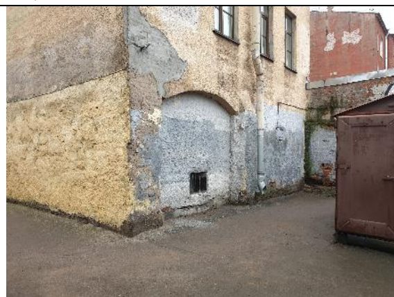
Фото №2: Вид здания снаружи
