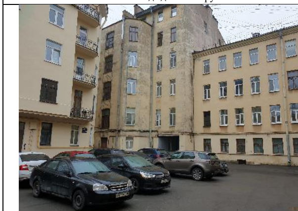
Фото №3: Вид здания снаружи
