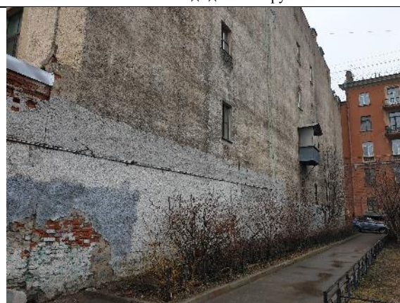
Фото №6: Вид здания снаружи
