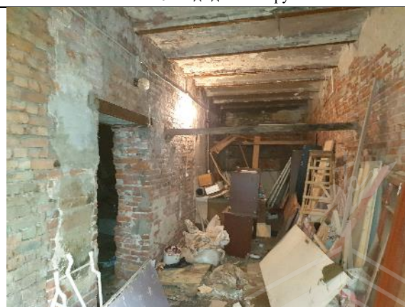
Фото №8: Внутренняя отделка помещения
