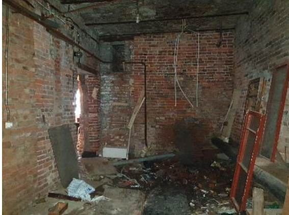
Фото №11: Внутренняя отделка помещения
