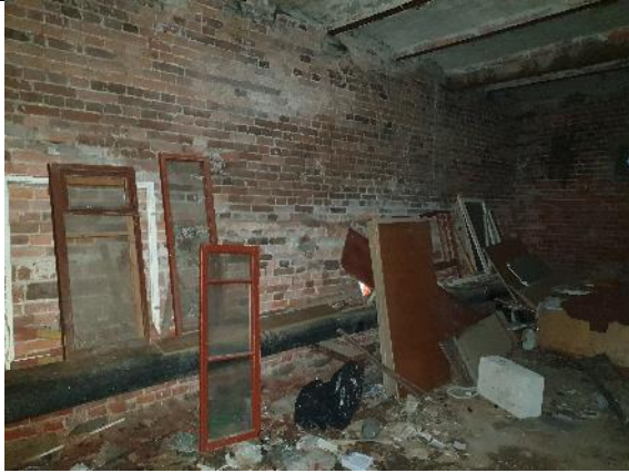
Фото №9: Внутренняя отделка помещения
