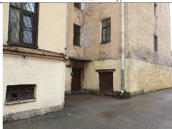
Фото №4: Вид здания снаружи
