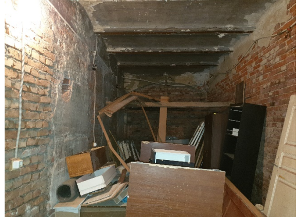
Фото №12: Внутренняя отделка помещения
