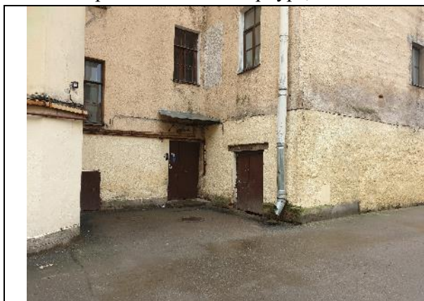
Фото №1: Вид здания снаружи
