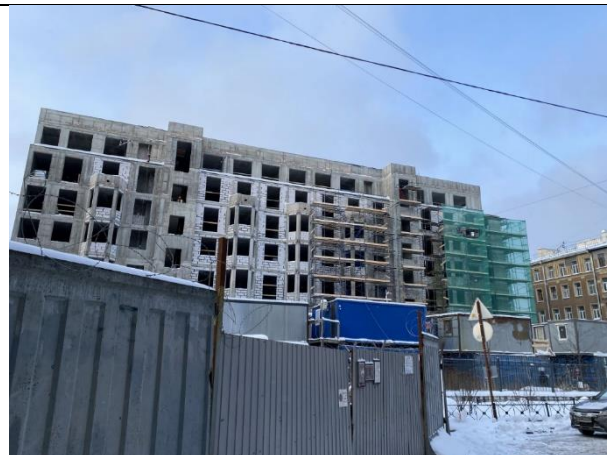
Фото 16. Ближайшее окружение (территория около Объекта оценки).
