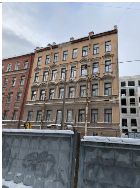
Фото 4. Фасадная часть здания по адресу: Тележная ул., д. 21, литера А.
