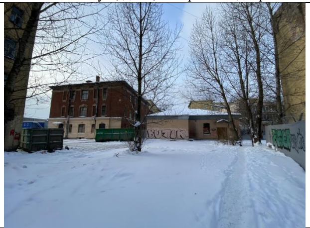
Фото 12. Ближайшее окружение (территория около Объекта оценки).
