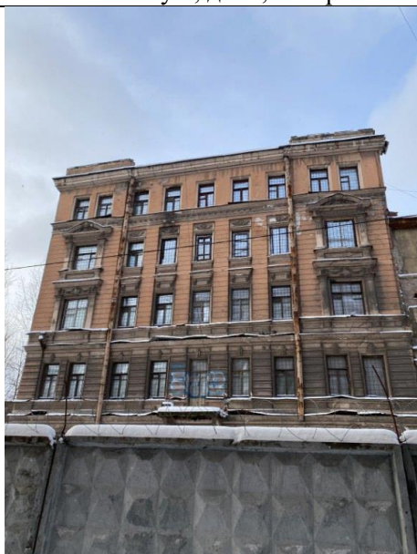
Фото 7. Фасадная часть здания по адресу: Тележная ул., д. 29, литера А.
