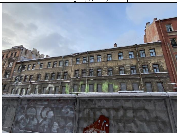
Фото 6. Фасадная часть здания по адресу: Тележная ул., д. 25-27, литера А.
