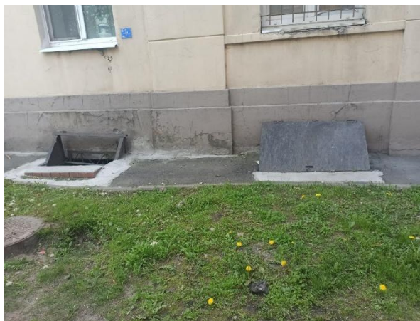
Фото 10. Вид окон Объекта оценки, с улицы
