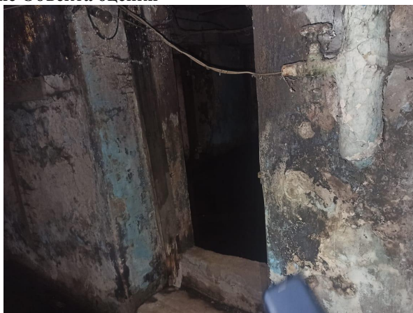
Фото 12. Вход в помещение 3-Н
