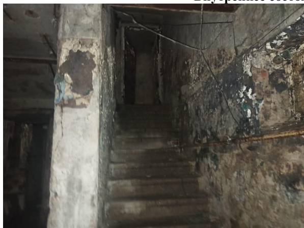
Фото 11. Выход к пожарному входу (заложен)
