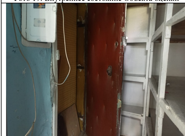
Фото 19. Внутреннее состояние Объекта оценки (вид входа в помещение с ЛК № 13)
