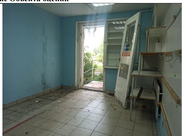
Фото 14. Внутреннее состояние Объекта оценки
