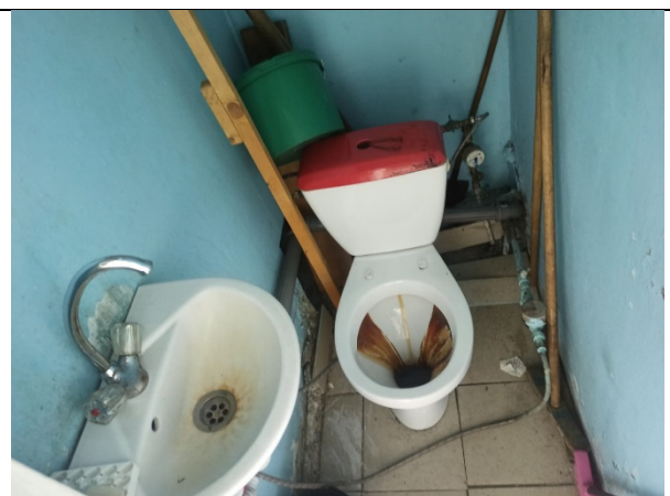
Фото 18. Внутреннее состояние Объекта оценки
