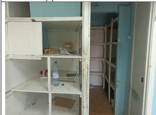
Фото 15. Внутреннее состояние Объекта оценки
