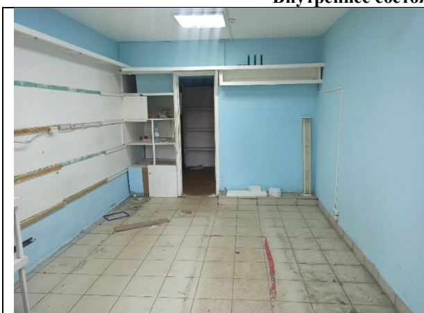
Фото 13. Внутреннее состояние Объекта оценки
