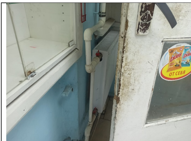
Фото 17. Внутреннее состояние Объекта оценки
