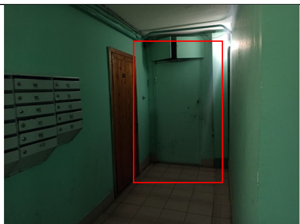
Фото 12. Вход в помещение Объекта оценки (вид входа в помещение с ЛК № 13)
