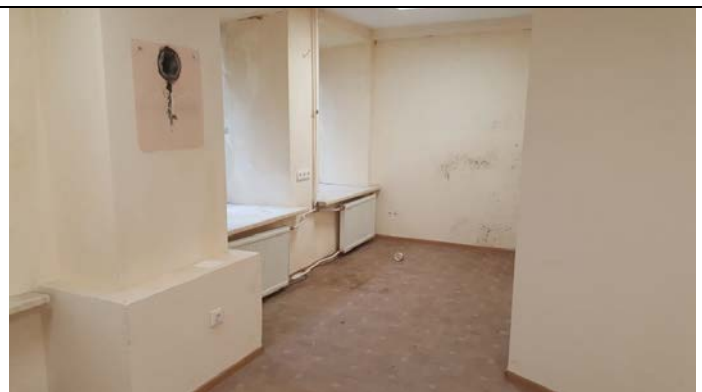
Фото 28. Типичное состояние Объекта оценки
