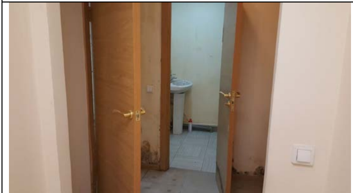
Фото 29. Типичное состояние Объекта оценки
