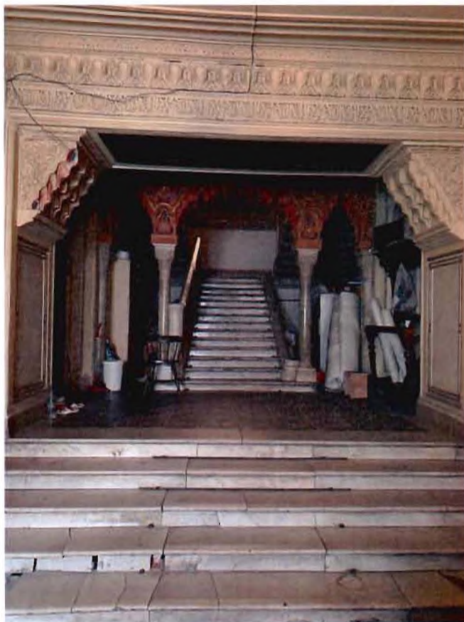
7. Лестница с Литейного пр. в кв. 12. Фрагмент.
