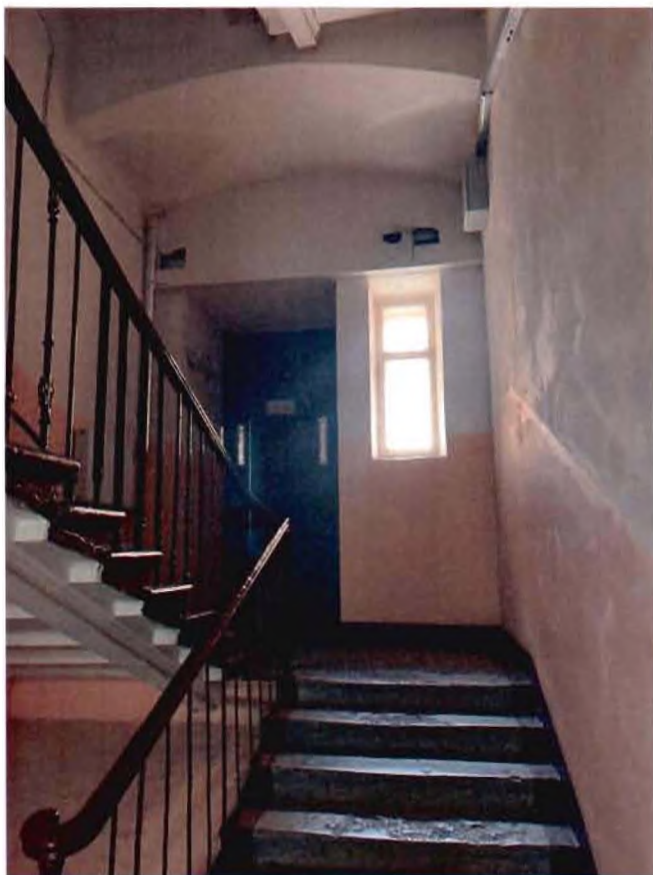
6. Лестница с ул. Короленко. Фрагмент.
