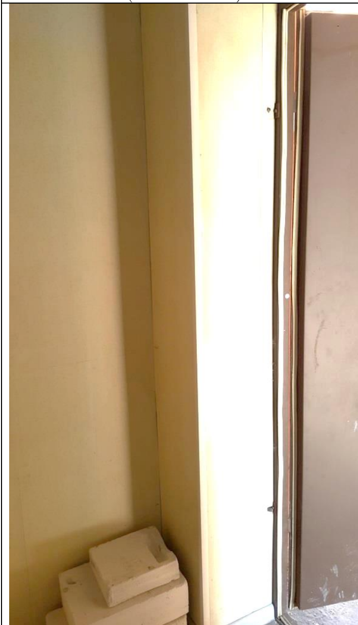
Фото 17. Состояние внутренней отделки Объекта оценки
