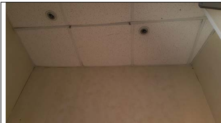
Фото 15. Состояние отделки Объекта оценки (состояние потолка)
