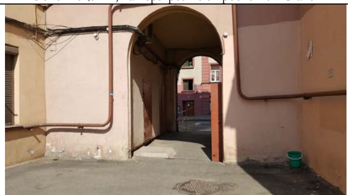
Фото 12. Вид арки, где расположен Объект оценки со стороны двора
