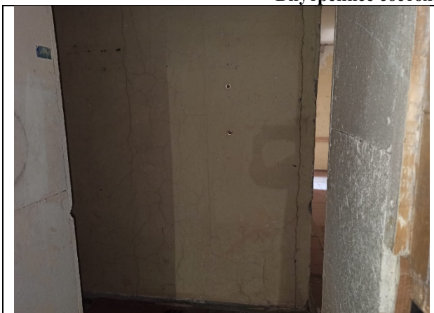
Фото 11. Внутреннее состояние Объекта оценки
