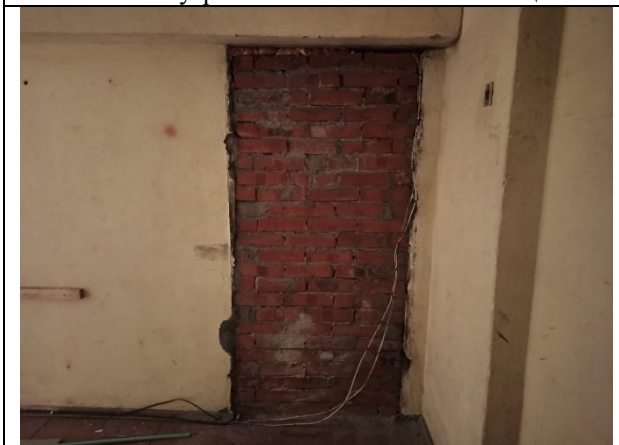
Фото 13. Внутреннее состояние Объекта оценки
