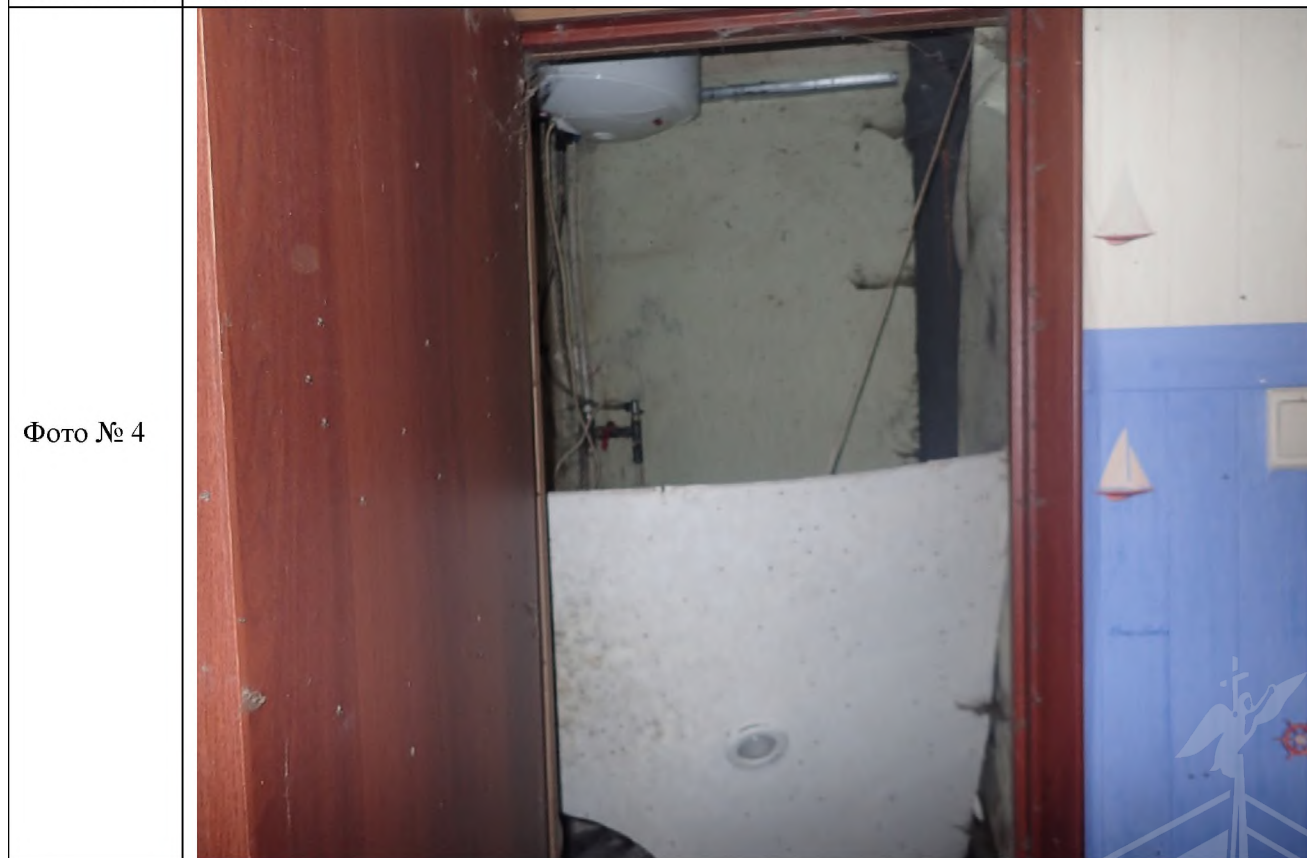
Описание: между ч.п. 3 и ч.п. 4 оборудован дверной проем
