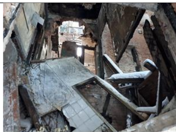
Фото 6. Состояние межэтажных перекрытий и окон Объекта оценки.
