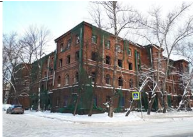
Фото 2. Вид здания, в котором расположен Объект оценки
