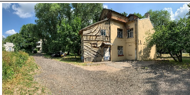
Фото № 3 – Фасад здания
