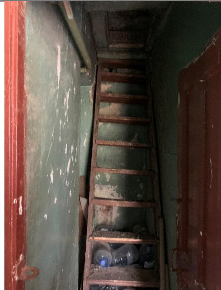
Фото № 14 - Внутреннее состояние
