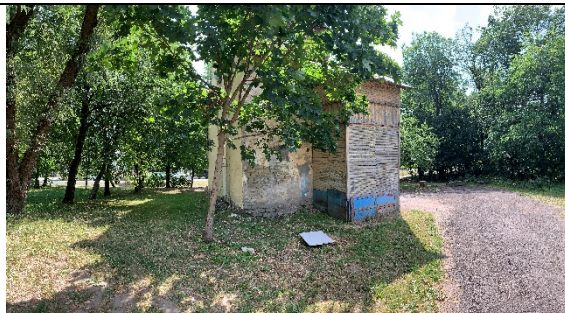
Фото № 4 – Фасад здания
