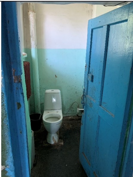
Фото № 15 - Внутреннее состояние
