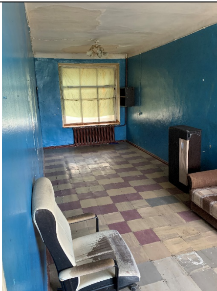
Фото № 9 - Внутренне состояние
