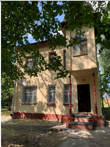
Фото № 1 – Фасад здания
