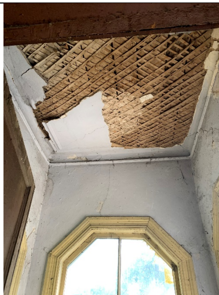
Фото № 6 - Внутренне состояние
