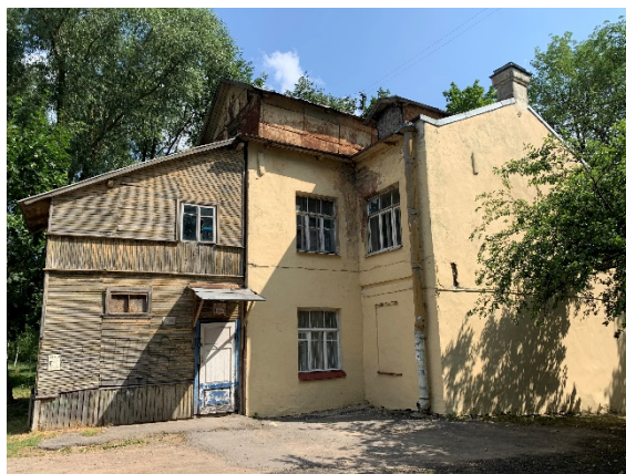
Фото № 2 – Фасад здания
