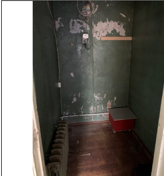
Фото № 13 - Внутреннее состояние
