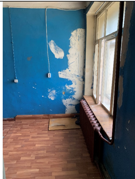
Фото № 10 - Внутренне состояние
