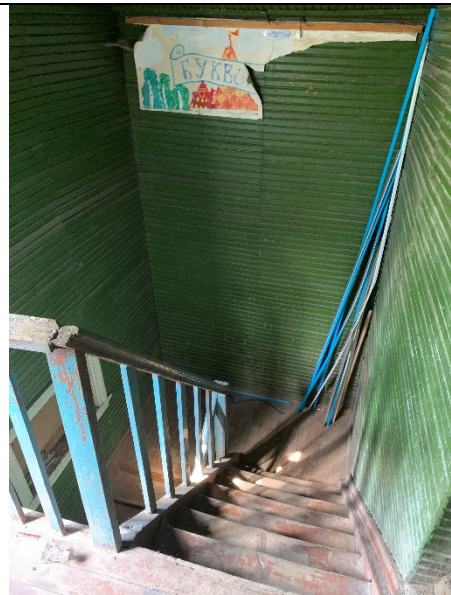
Фото № 16 - Внутреннее состояние
