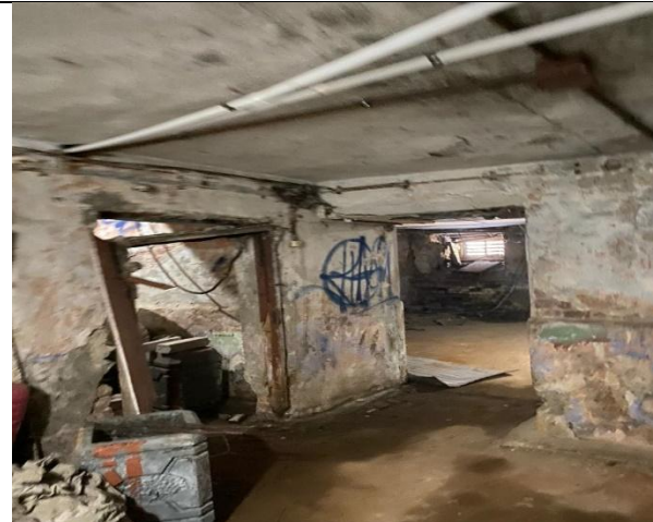
Фото 17. Внутреннее состояние Объекта оценки
