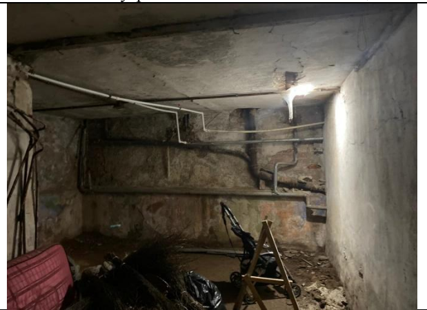
Фото 16. Внутреннее состояние Объекта оценки (транзитные трубы)
