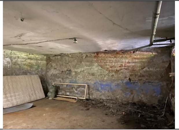
Фото 14. Внутреннее состояние Объекта оценки
