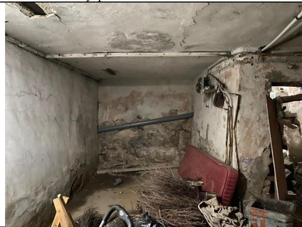
Фото 15. Внутреннее состояние Объекта оценки
