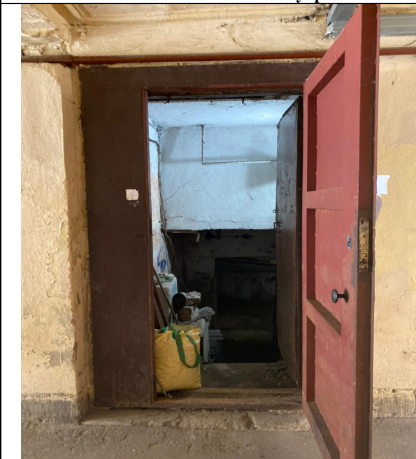
Фото 11. Вход в помещение 1-Н Объекта оценки
