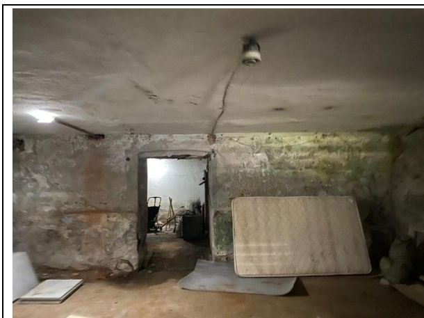
Фото 19. Внутреннее состояние Объекта оценки
