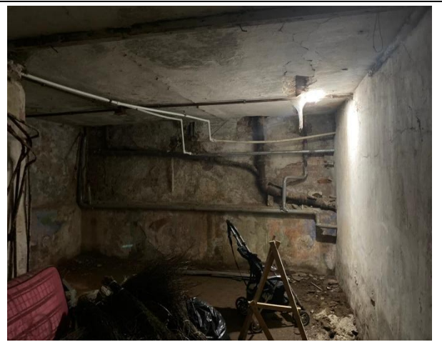
Фото 18. Внутреннее состояние Объекта оценки
