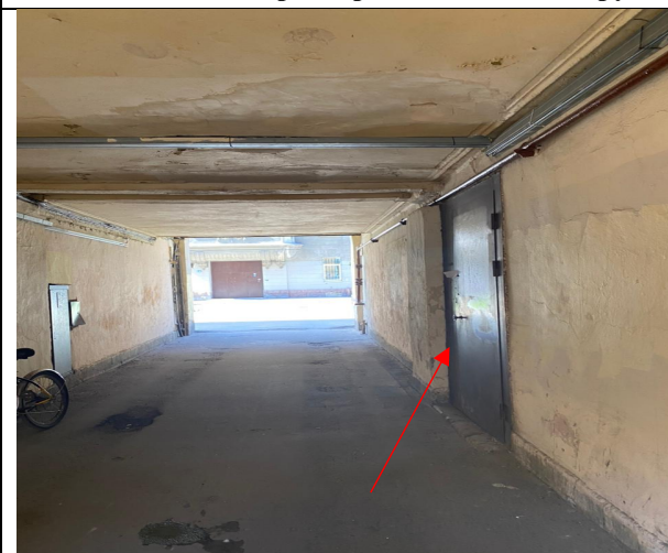
Фото 9. Отдельный вход со двора и окно Объекта
