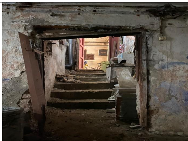
Фото 20. Внутреннее состояние Объекта оценки
