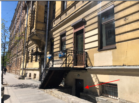
Фото № 1 – Вход в помещение
