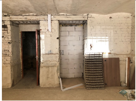
Фото № 10 - Внутренне состояние
