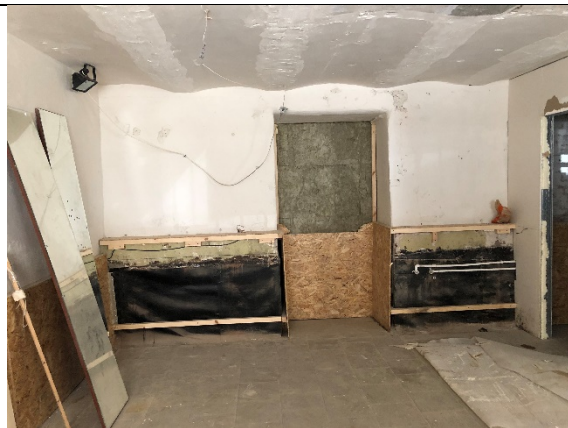
Фото № 4 – Внутреннее состояние
