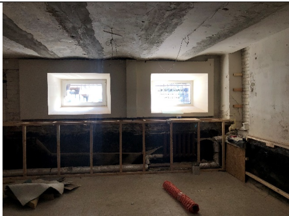
Фото № 5 – Внутреннее состояние
