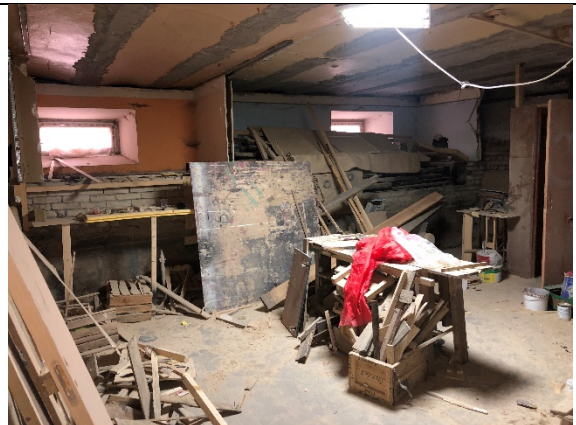
Фото № 14 - Внутреннее состояние
