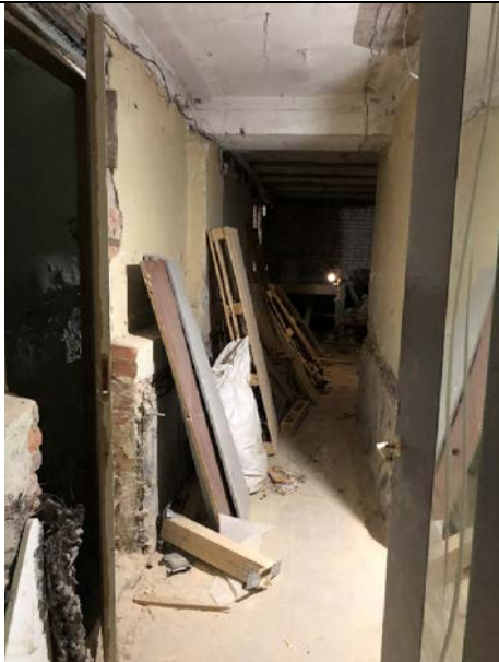
Фото № 17 - Внутреннее состояние
