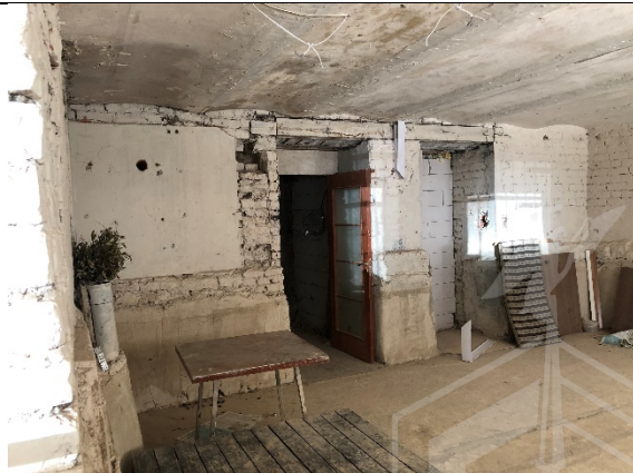
Фото № 8 - Внутренне состояние
