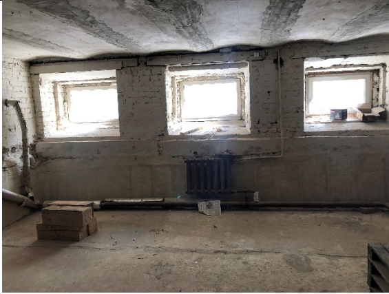
Фото № 9 - Внутренне состояние
