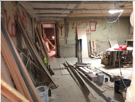
Фото № 13 - Внутреннее состояние
