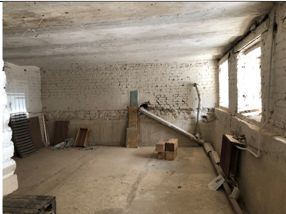
Фото № 7 - Внутренне состояние
