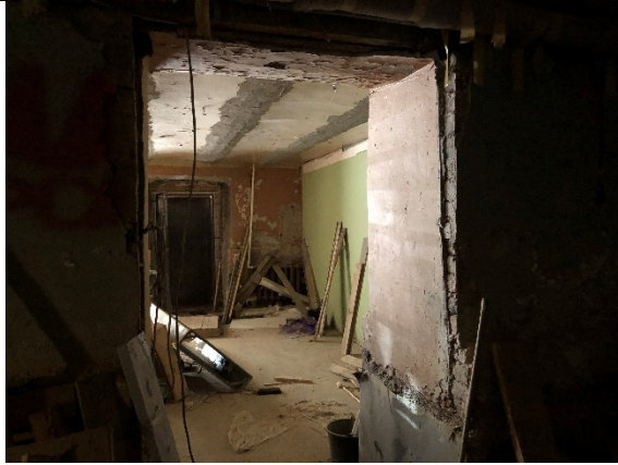
Фото № 23 - Внутреннее состояние
