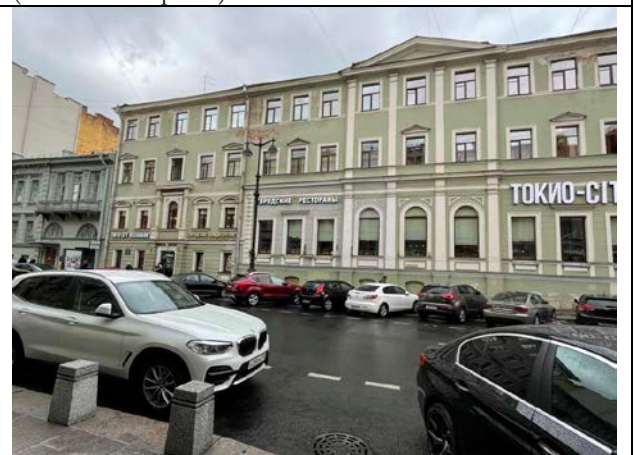
Фото 14. Вид здания Объекта оценки
