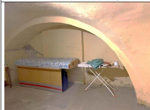
Фото 39. Типичное состояние Объекта оценки
