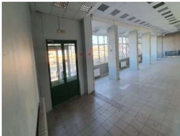
Фото 2 Вид и состояние оцениваемого объекта. Вход в помещение.
