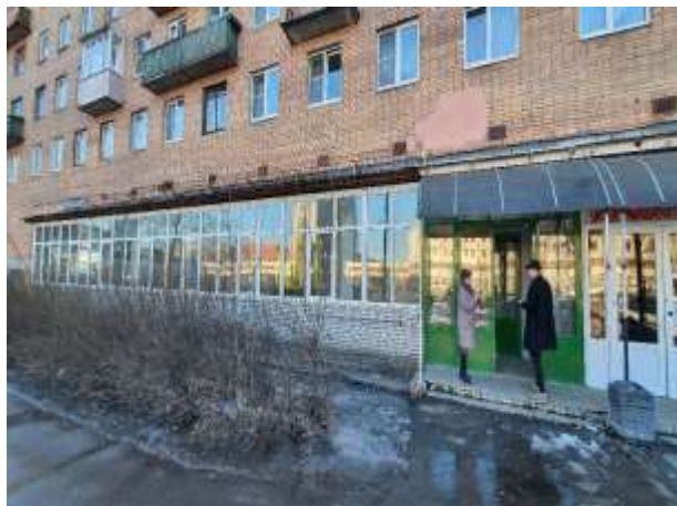
Фото 1. Вход в помещение
