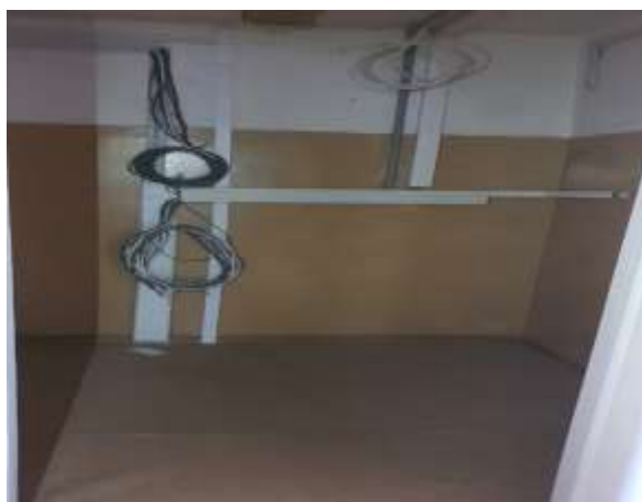
Фото 17. Вид и состояние оцениваемого объекта
