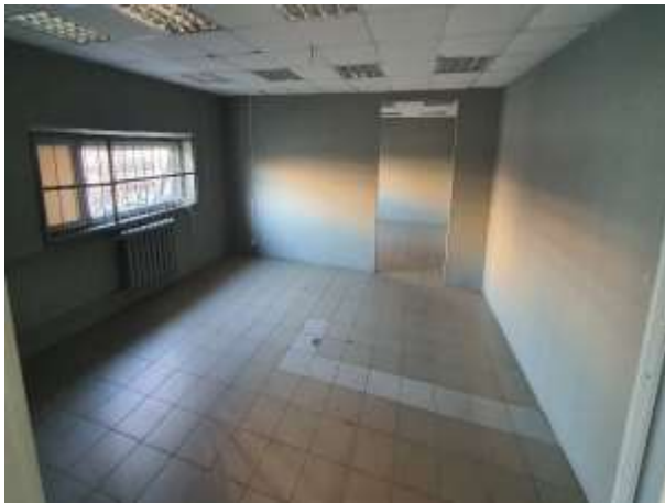
Фото 7. Вид и состояние оцениваемого объекта
