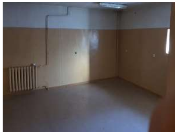
Фото 12 Вид и состояние оцениваемого объекта
