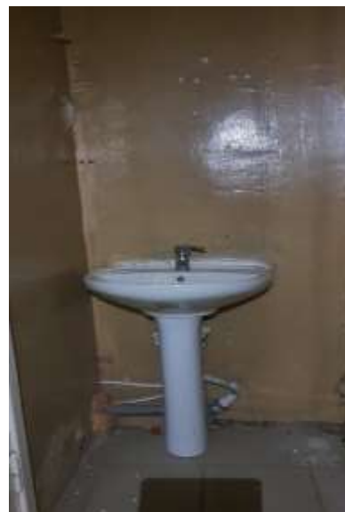
Фото 22 Вид и состояние оцениваемого объекта
