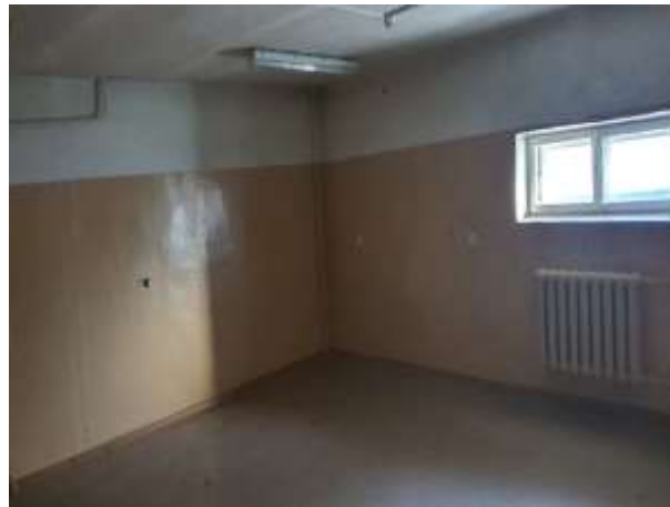
Фото 8 Вид и состояние оцениваемого объекта
