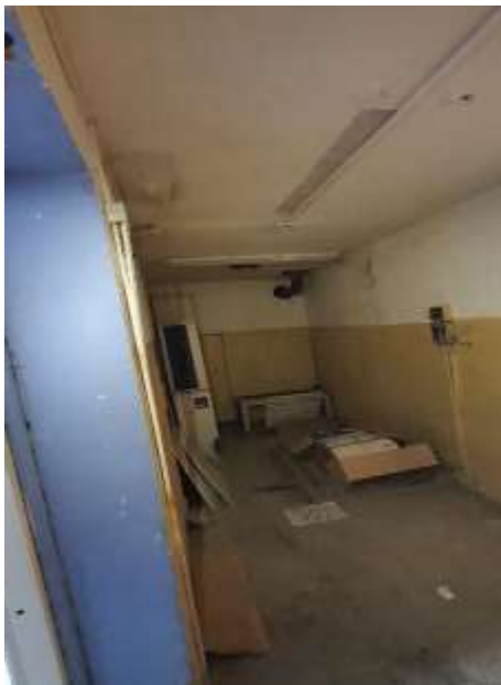
Фото 13. Вид и состояние оцениваемого объекта
