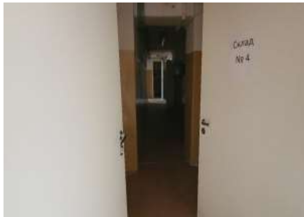
Фото 16 Вид и состояние оцениваемого объекта
