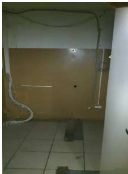
Фото 10 Вид и состояние оцениваемого объекта
