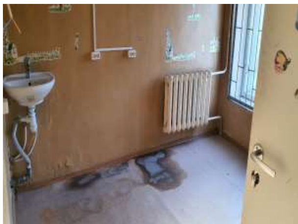
Фото 23. Вид и состояние оцениваемого объекта
