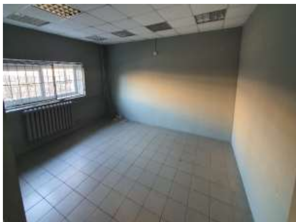
Фото 3. Вид и состояние оцениваемого объекта
