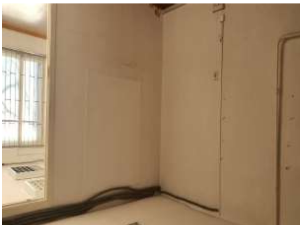
Фото 11. Вид и состояние оцениваемого объекта
