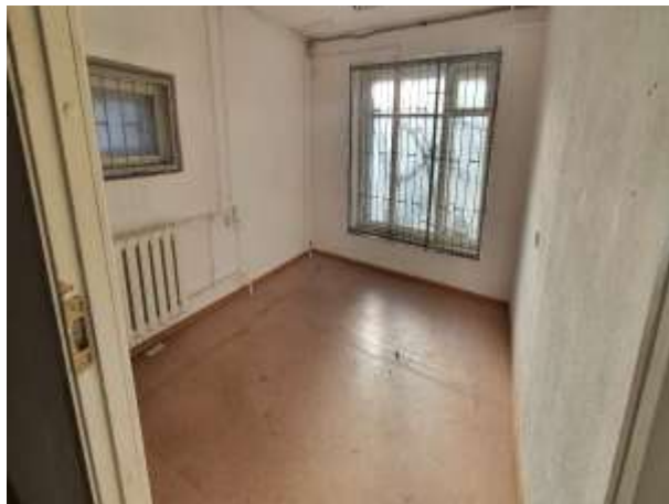
Фото 15. Вид и состояние оцениваемого объекта
