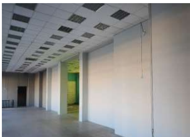
Фото 5. Вид и состояние оцениваемого объекта
