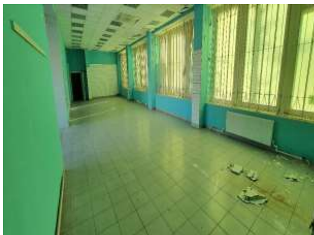
Фото 4 Вид и состояние оцениваемого объекта
