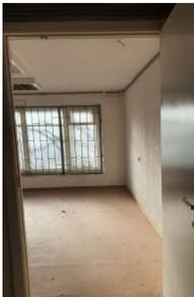
Фото 19. Вид и состояние оцениваемого объекта
