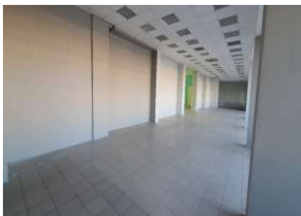
Фото 6 Вид и состояние оцениваемого объекта
