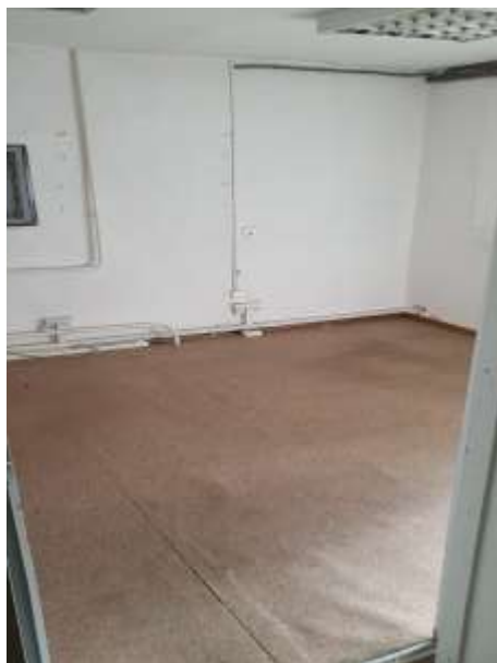
Фото 9. Вид и состояние оцениваемого объекта
