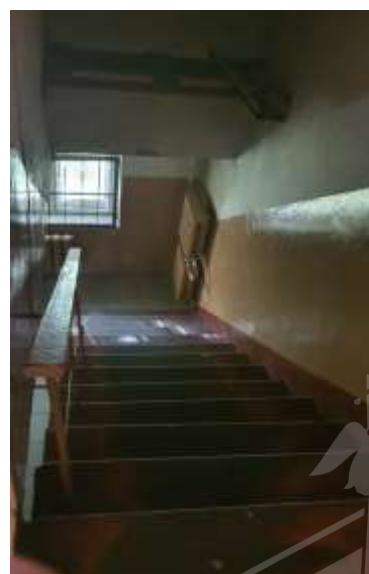
Фото 24 Вид и состояние оцениваемого объекта
