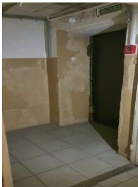
Фото 20 Вид и состояние оцениваемого объекта
