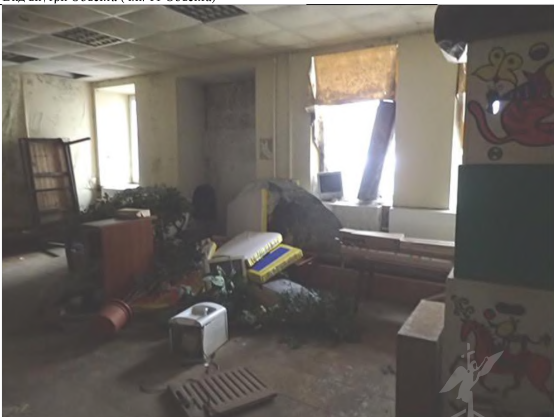
Описание: Вид внутри Объекта (ч.п. 11 Объекта)
