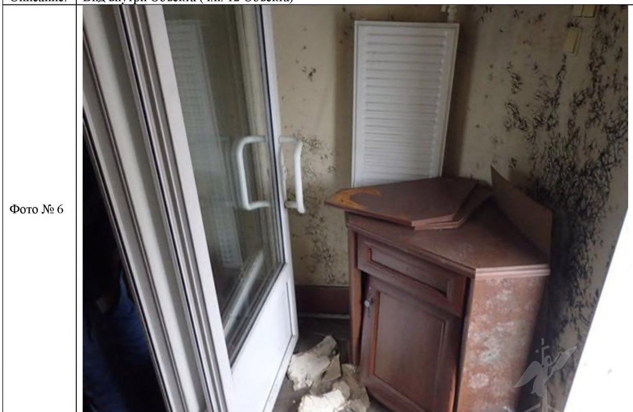
Описание: Вид внутри Объекта (ч.п. 12 Объекта)
