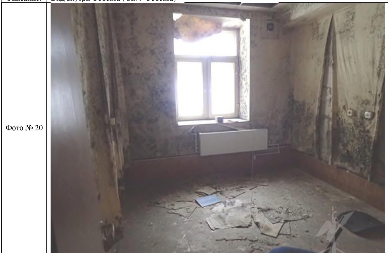
Описание: Вид внутри Объекта (ч.п. 9 Объекта)
