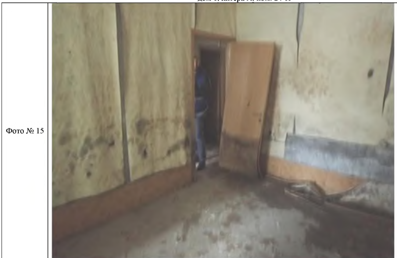
Описание: Вид внутри Объекта (ч.п. 3 Объекта)
