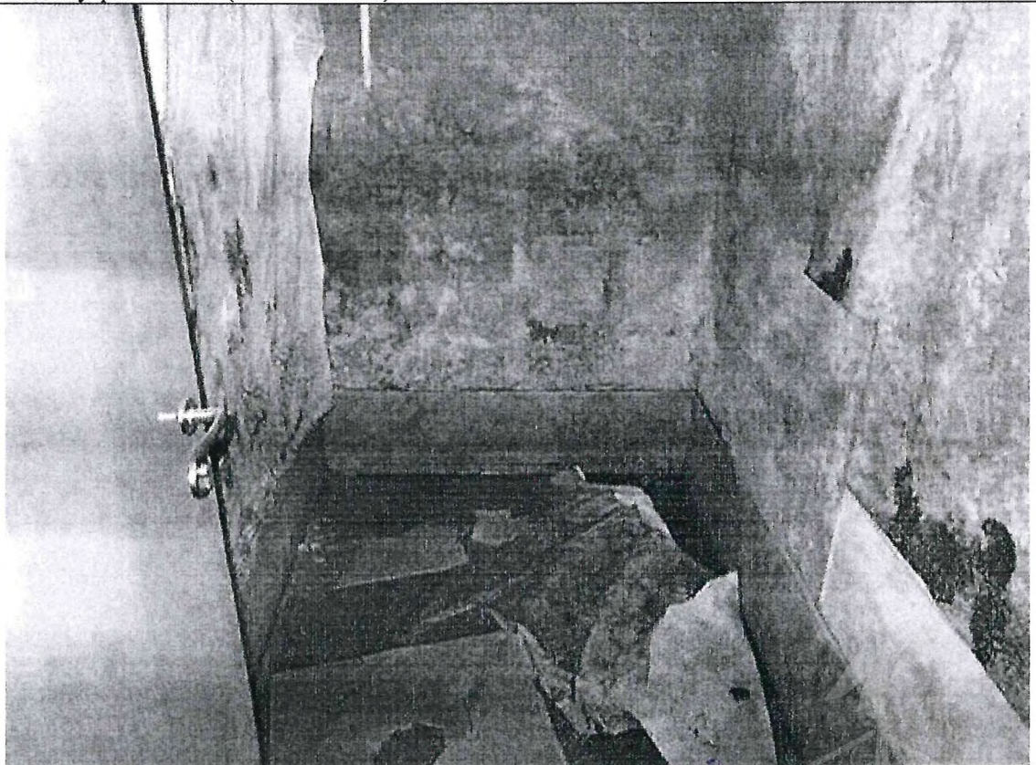
Описание: Вид внутри Объекта (ч.п. 5 Объекта)
