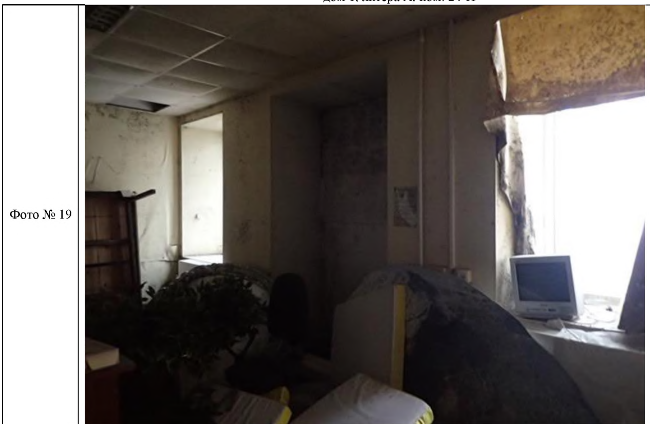
Описание: Вид внутри Объекта (ч.п. 9 Объекта)
