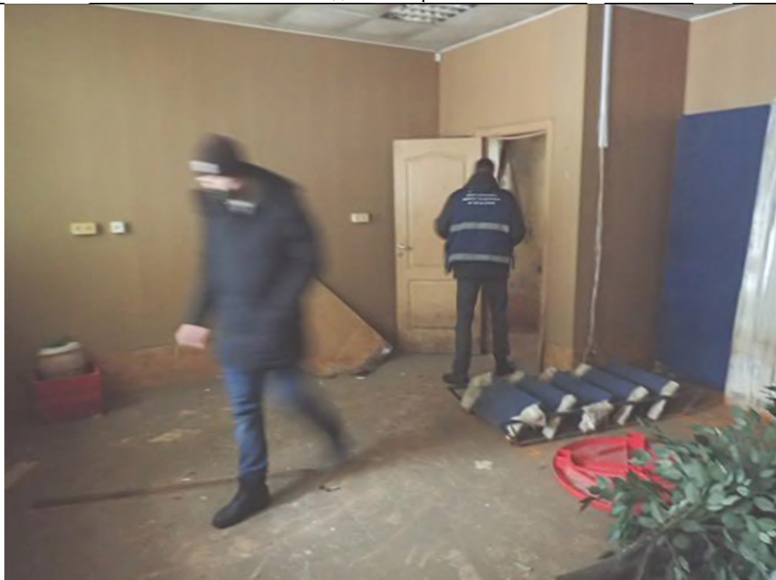
Описание: Вид внутри Объекта (ч.п. 8 Объекта)
