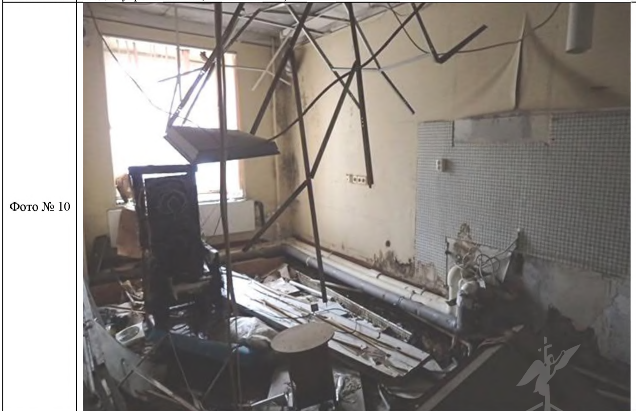
Описание: Вид внутри Объекта (ч.п. 2 Объекта)
