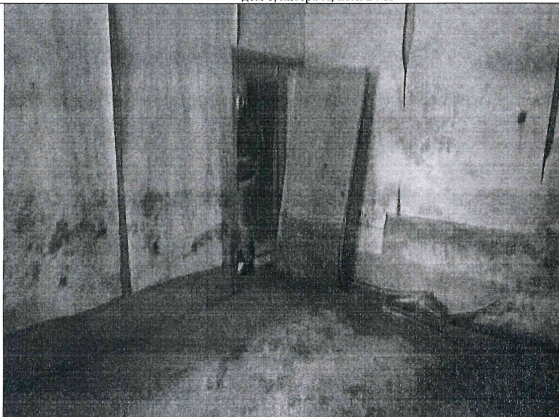
Описание: Вид внутри Объекта (ч.п. 3 Объекта)
