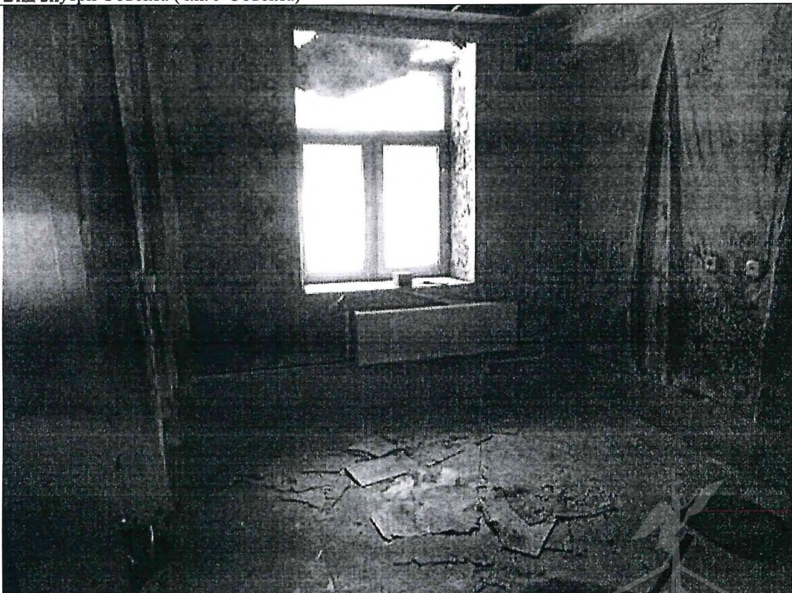
Описание: Вид внутри Объекта (ч.п. 9 Объекта)
