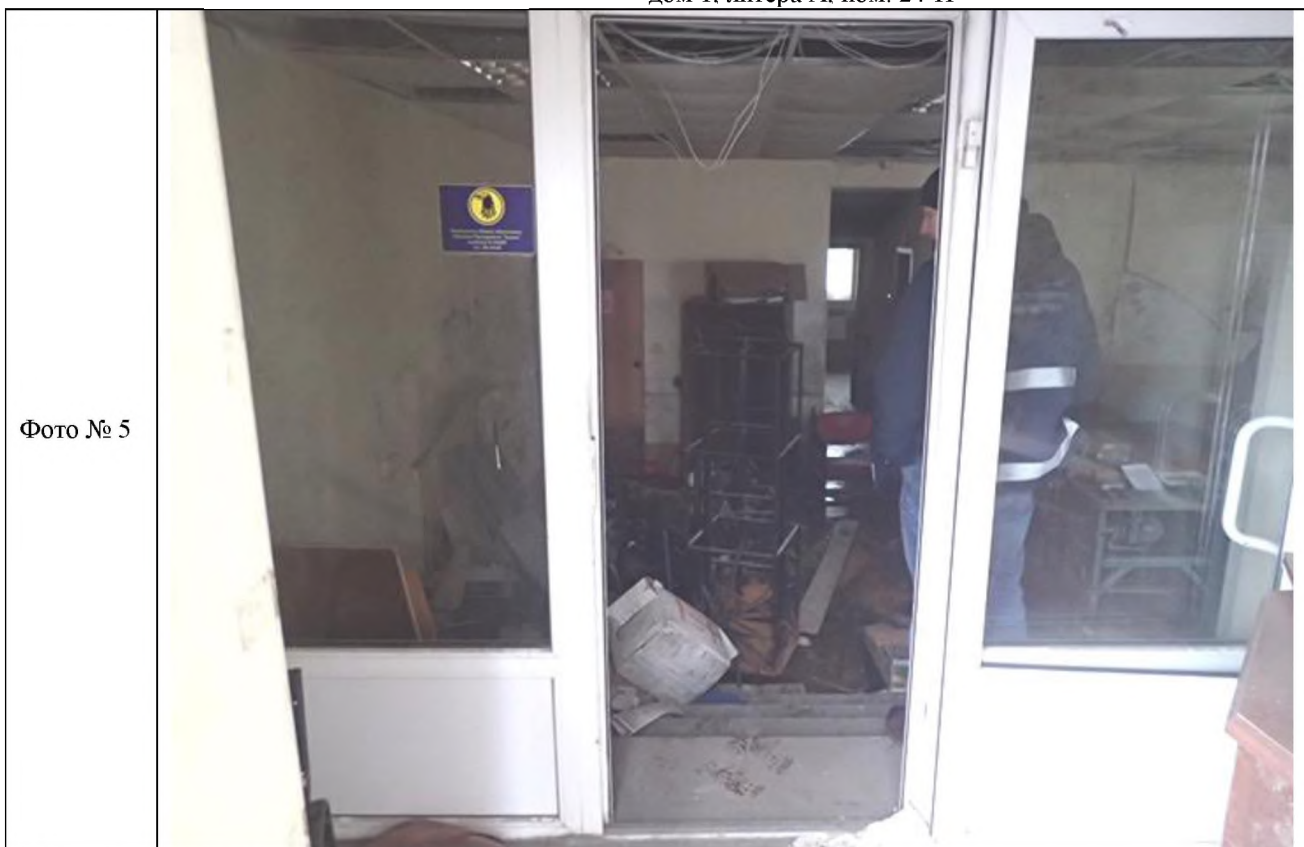
Описание: Вид внутри Объекта (ч.п. 12 Объекта)
