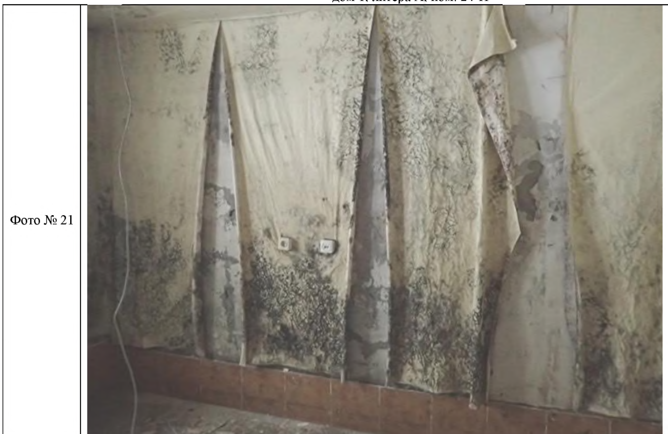
Описание: Вид внутри Объекта (ч.п. 9 Объекта)
