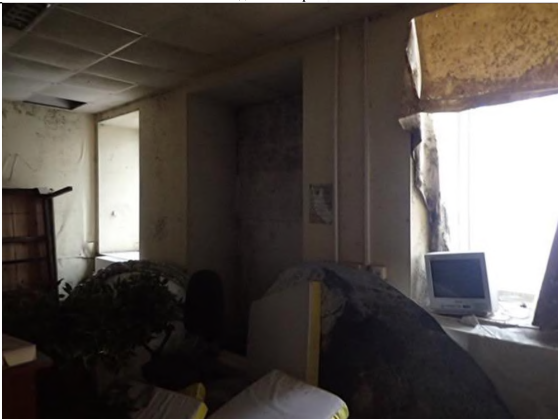
Описание: Вид внутри Объекта (ч.п. 9 Объекта)
