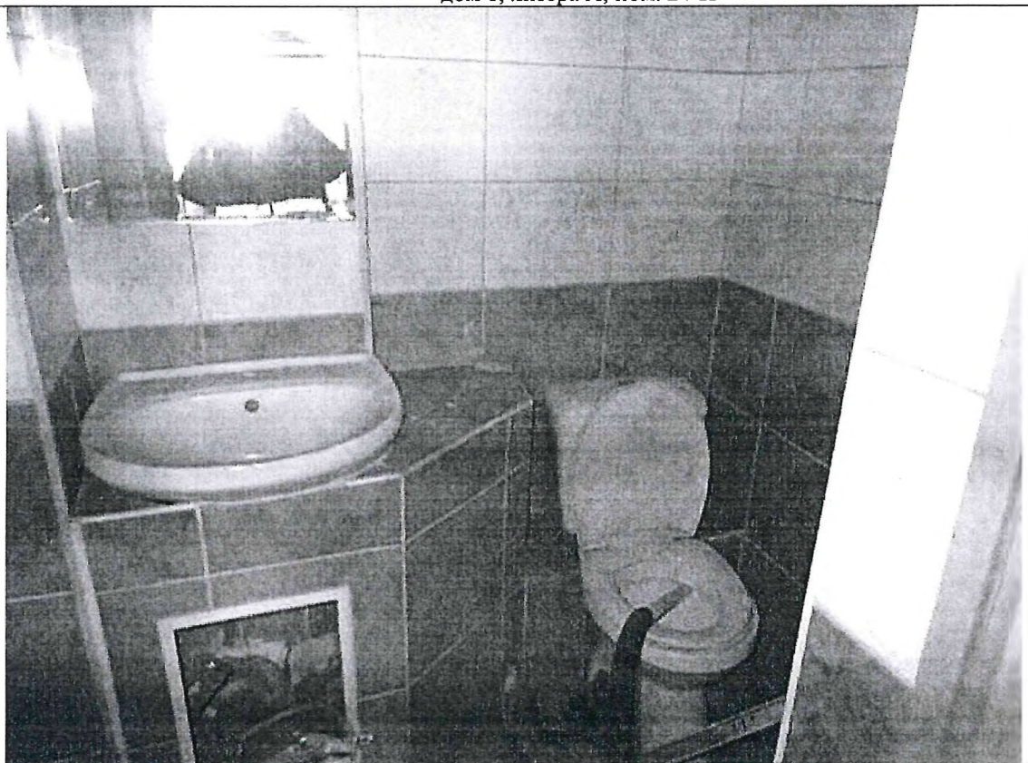
Описание: Вид внутри Объекта (ч.п. 7 Объекта)
