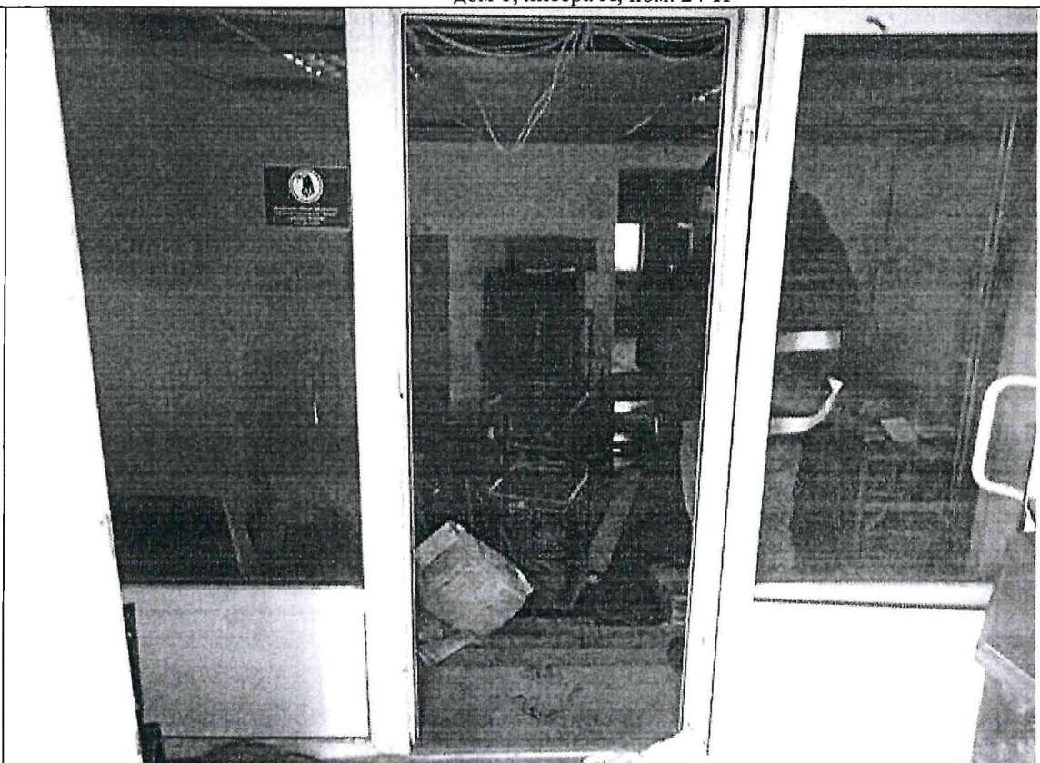
Описание: Вид внутри Объекта (ч.п. 12 Объекта)
