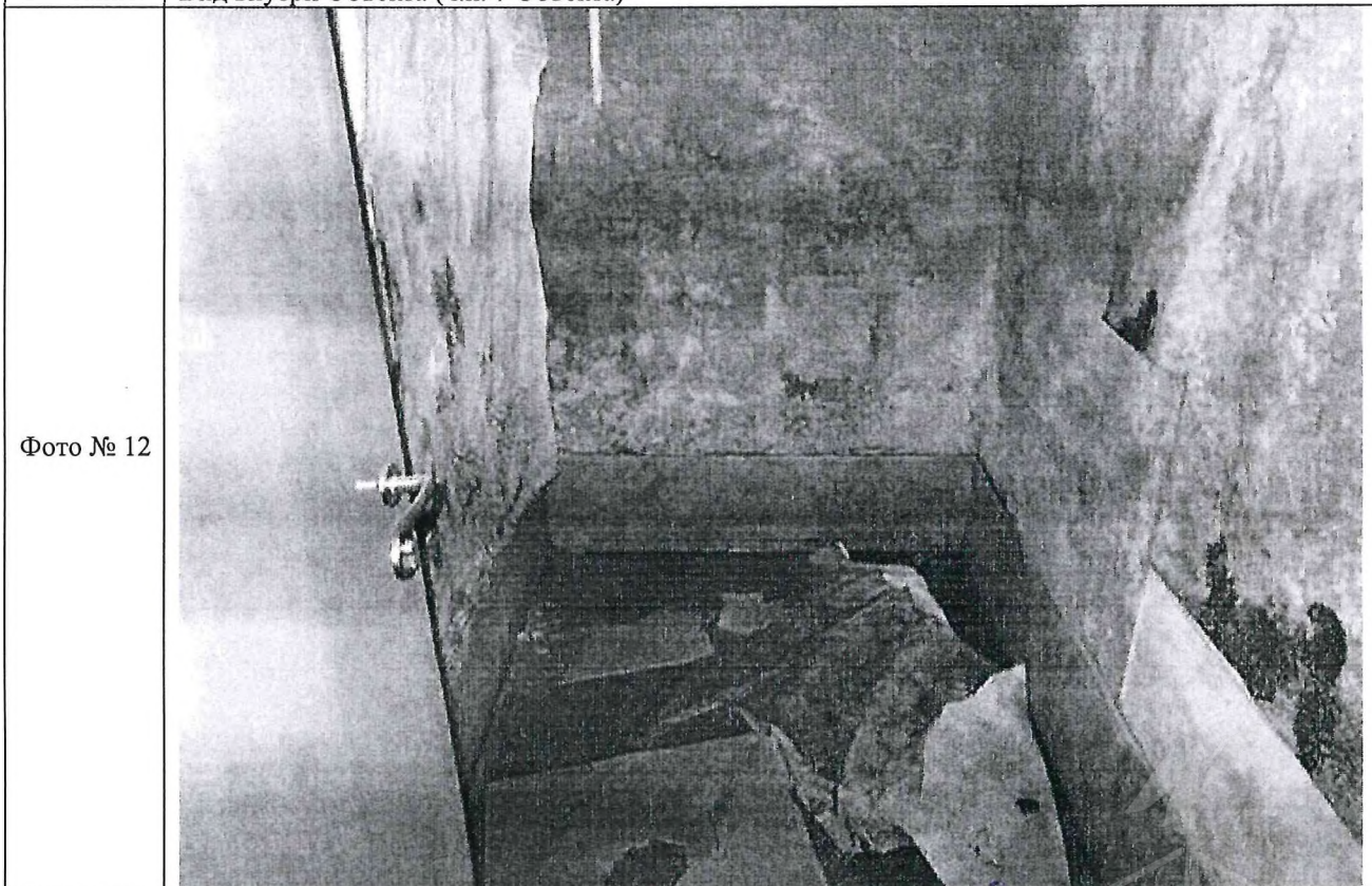
Описание: Вид внутри Объекта (ч.п. 5 Объекта)
