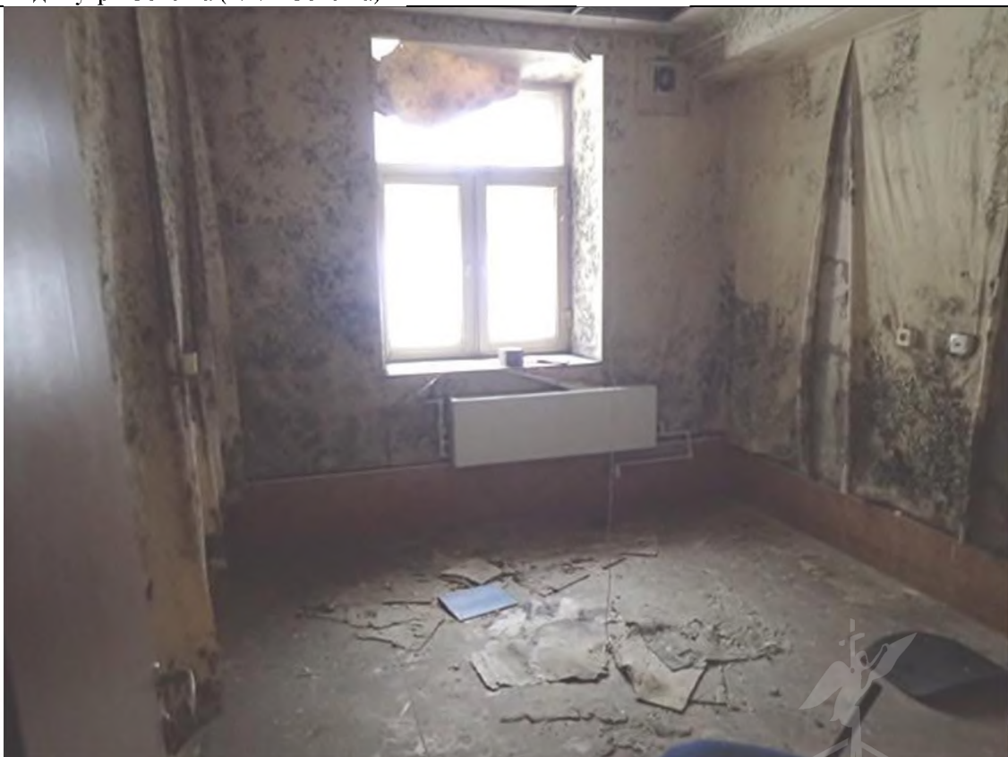
Описание: Вид внутри Объекта (ч.п. 9 Объекта)
