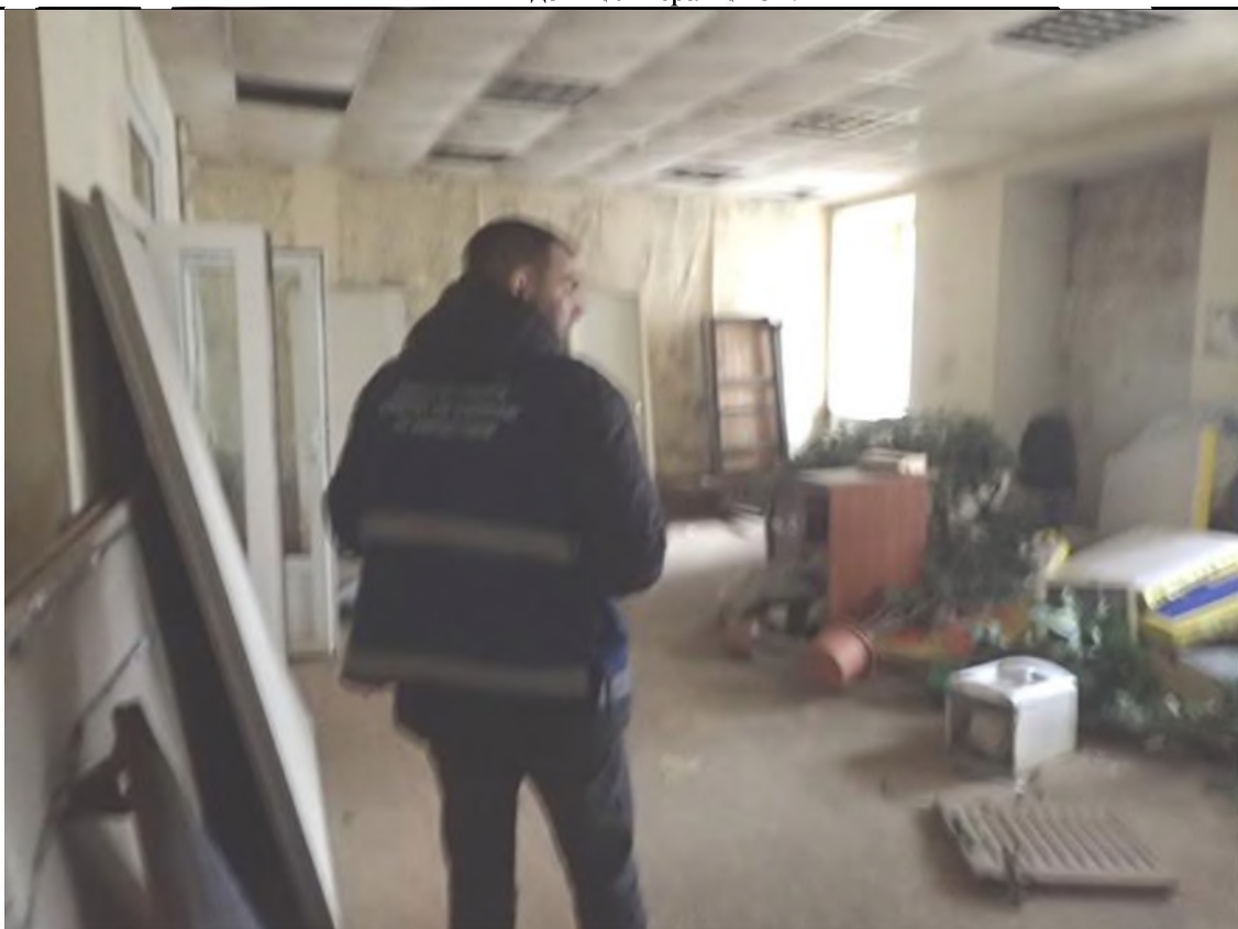
Описание: Вид внутри Объекта (ч.п. 11 Объекта)
