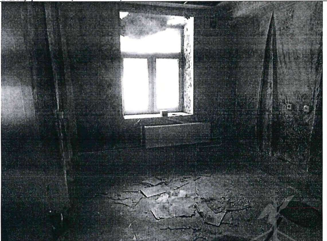
Описание: Вид внутри Объекта (ч.п. 9 Объекта)
