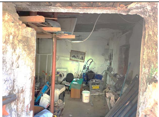
Фото 18. Типичное состояние Объекта оценки
