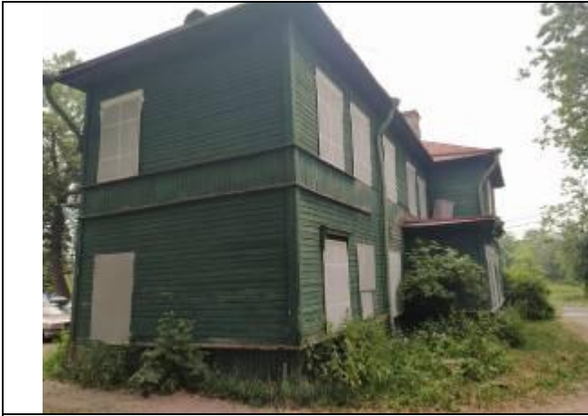
Фото 7. Вид на здание расположения Объекта оценки.
