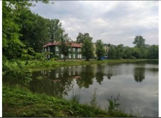
Фото 16. Вид на здание расположения Объекта оценки.
