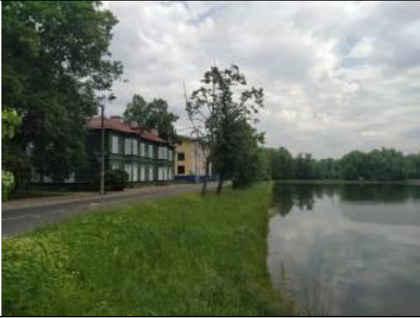
Фото 15. Вид на здание расположения Объекта оценки.
