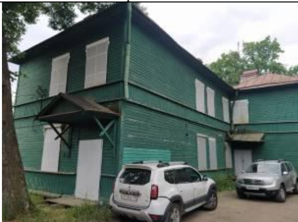
Фото 5. Вид на здание расположения Объекта оценки.
