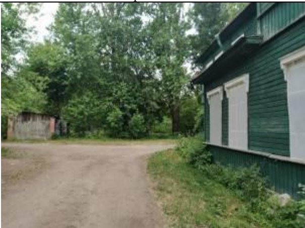
Фото 13. Вид на здание расположения Объекта оценки.
