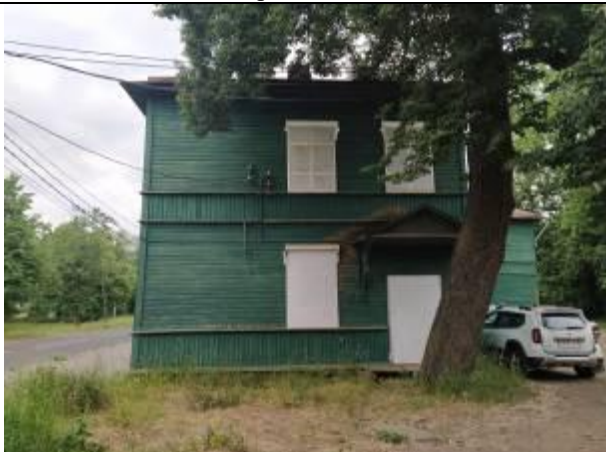
Фото 3. Вид на здание расположения Объекта оценки.
