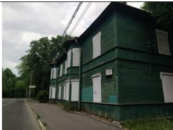
Фото 2. Вид на здание расположения Объекта оценки.
