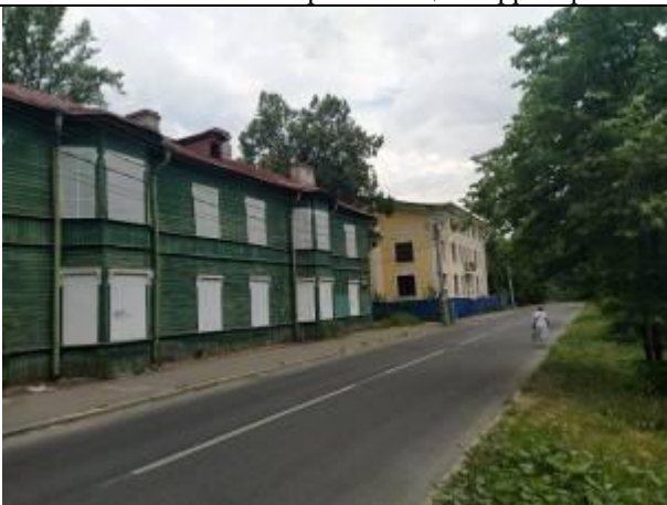
Фото 11. Вид на здание расположения Объекта оценки.
