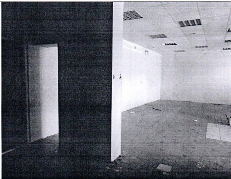
Описание: Вид внутри Объекта. В перегородке ч.п. 2 оборудован второй дверной проем
