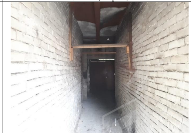
Фото 16. Внутреннее состояние здания (вид через решетку заваренного в здание входа)
