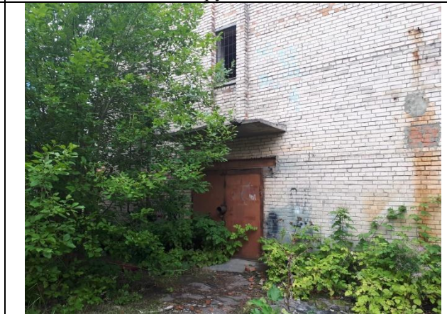
Фото 12. Вид Объекта оценки. Вид входа в здание (закрыт)
