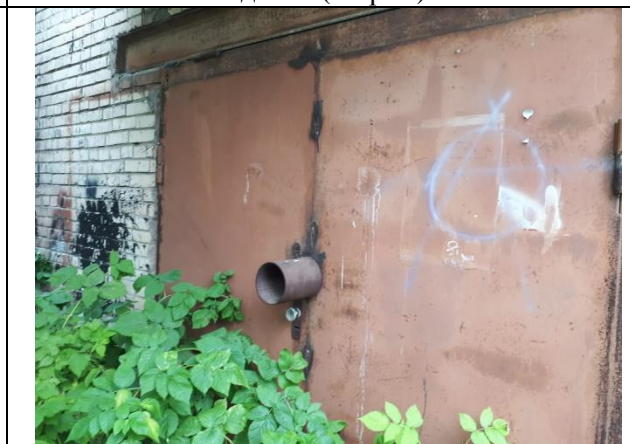
Фото 14. Вид Объекта оценки. Вид входа в здание (закрыт)
