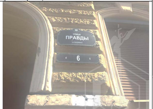
Фото 8. Адрес Объекта оценки
