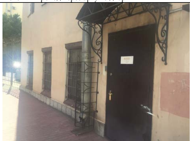
Фото 14. Вид на здание со стороны двора
