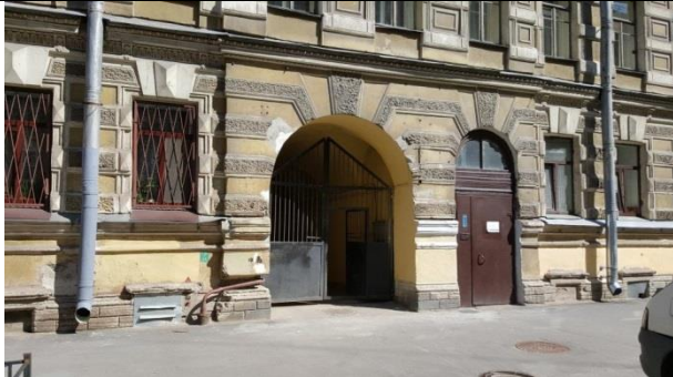
Фото 9. Вид арки во двор расположения Объекта оценки (вид со стороны улицы)
