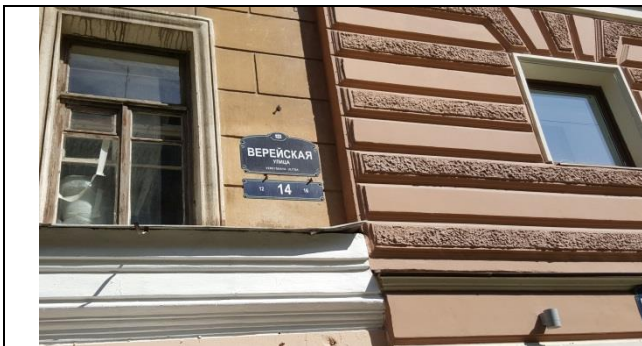
Фото 7. Адресная табличка на здании Объекта оценки
