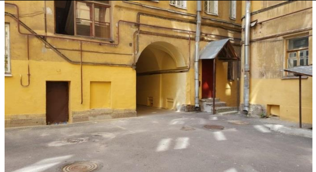
Фото 10. Проход через арку к Объекту оценки (вид со стороны двора)
