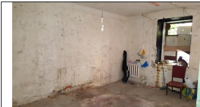
Фото 17. Типичное состояние Объекта оценки
