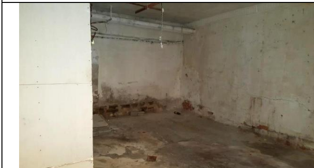
Фото 21. Типичное состояние Объекта оценки
