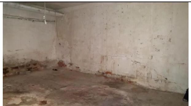
Фото 18. Типичное состояние Объекта оценки
