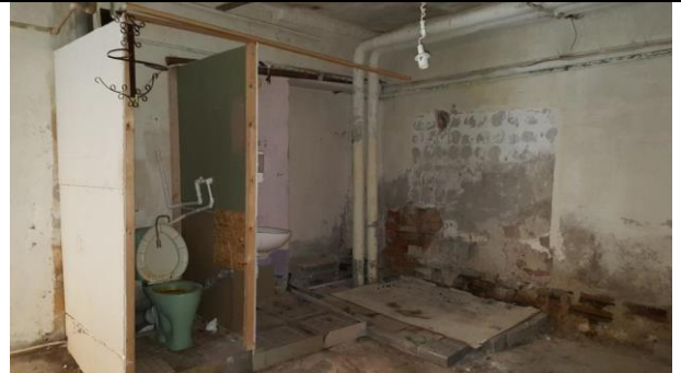
Фото 20. Типичное состояние Объекта оценки
