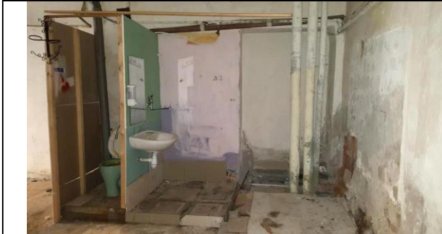
Фото 19. Типичное состояние Объекта оценки
