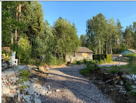
Фото № 6 - Территория земельного участка
