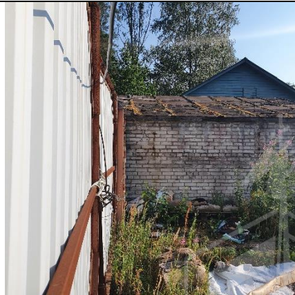
Фото № 8 - Территория земельного участка
