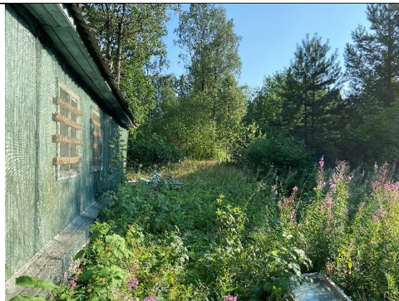
Фото № 18 - Территория земельного участка
