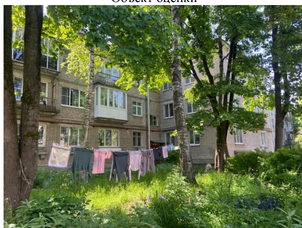
Фото 6. Вид здания, в котором расположен Объект оценки
