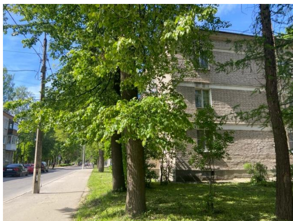
Фото 9. Вид здания, в котором расположен Объект оценки
