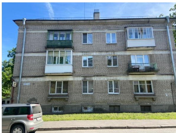
Фото 3. Вид здания, в котором расположен Объект оценки
