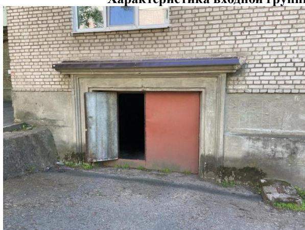
Фото 12. Отдельный вход с улицы (с торца здания)
