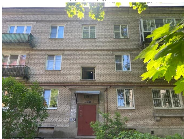
Фото 8. Вид здания, в котором расположен Объект оценки
