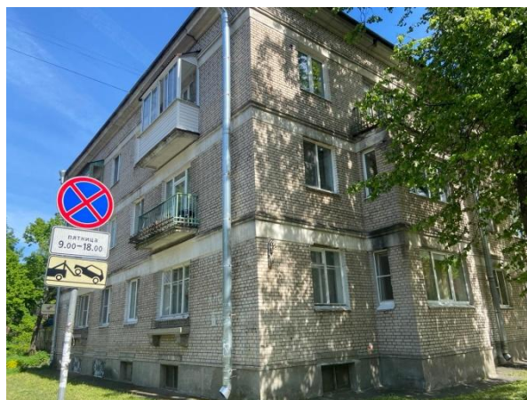
Фото 10. Вид здания, в котором расположен Объект оценки
