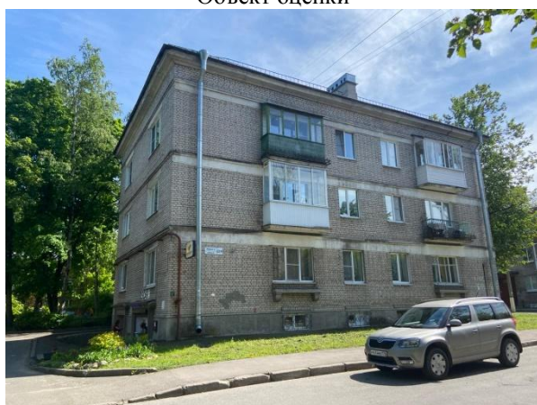
Фото 5. Вид здания, в котором расположен Объект оценки
