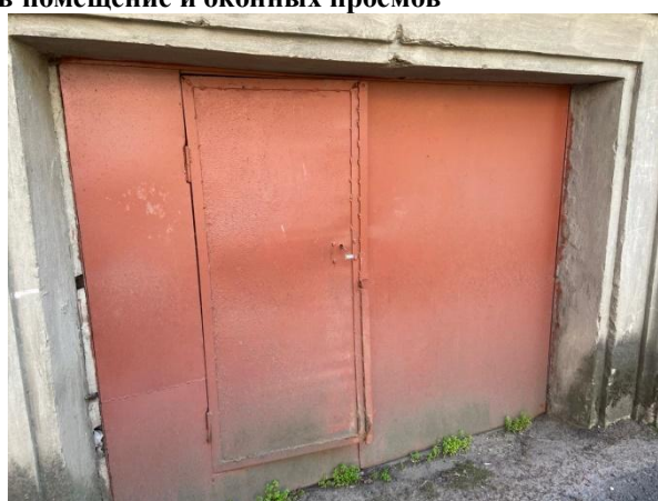
Фото 13. Отдельный вход с улицы (с торца здания)
