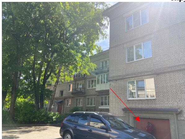
Фото 1. Вид здания, в котором расположен Объект оценки
