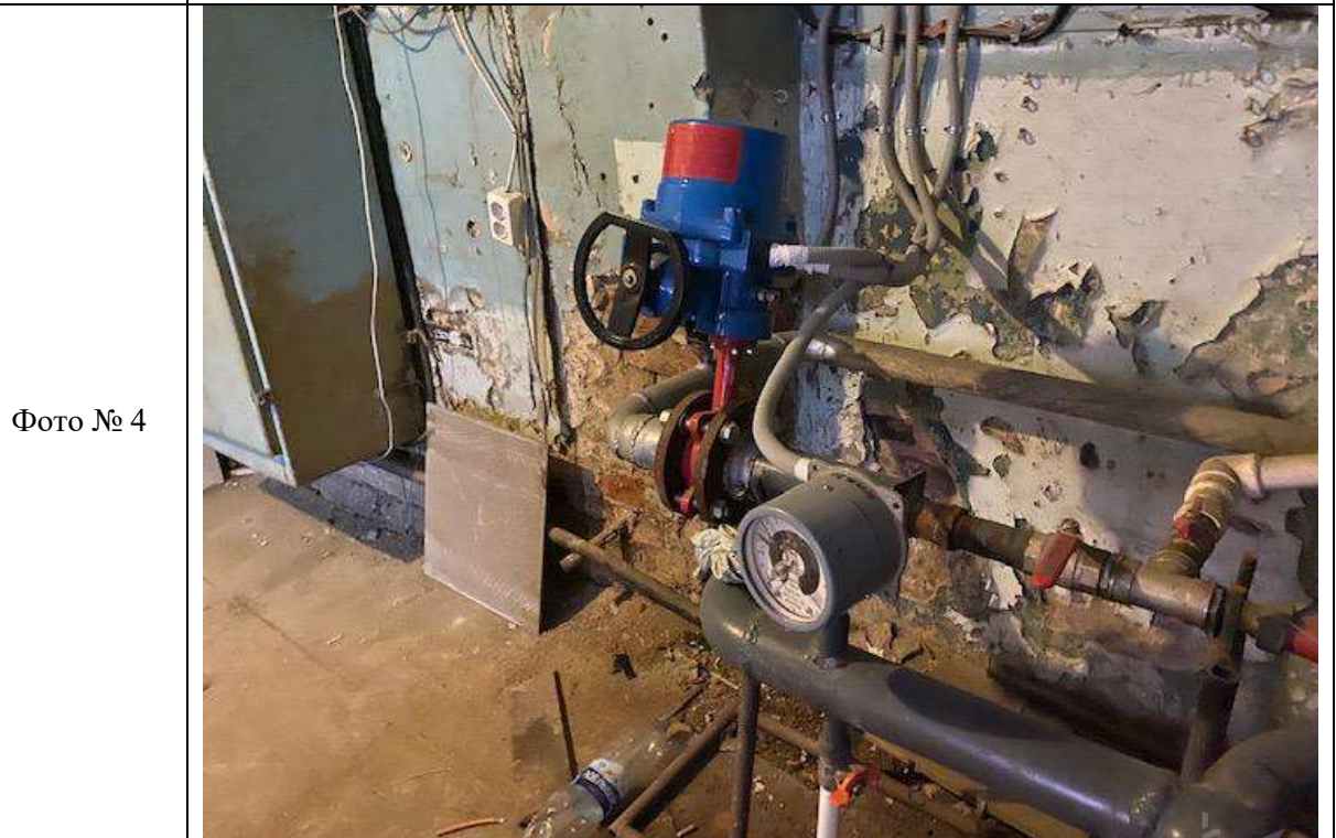
Описание: В ч.п. 2 Объекта размещен водомерный узел.
