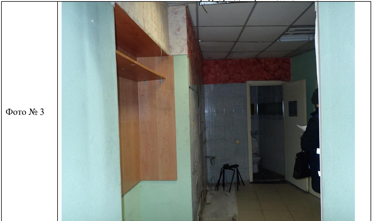
Описание: Вид внутри Объекта
