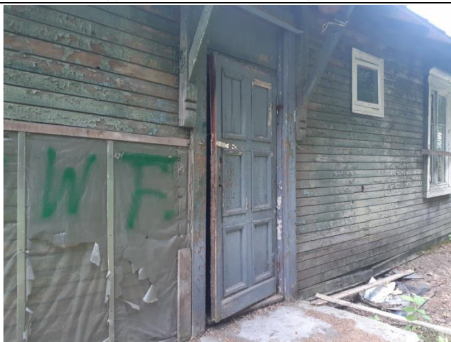
Фото 11. Вид на оцениваемый жилой дом в составе Объекта оценки
