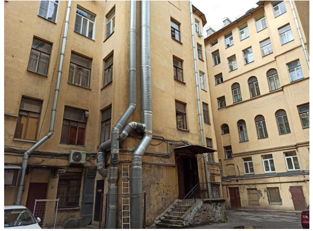
Фото 4. Вид здания, в котором расположен Объект оценки, со двора
