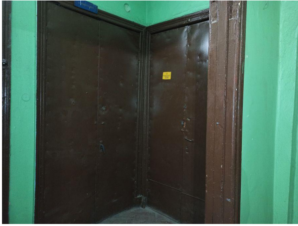
Фото 15. Вход 1, 2 в помещение
