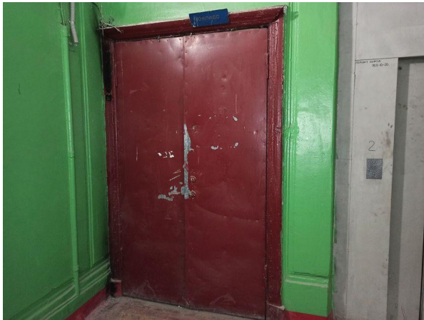
Фото 17. Вход 4 в помещение
