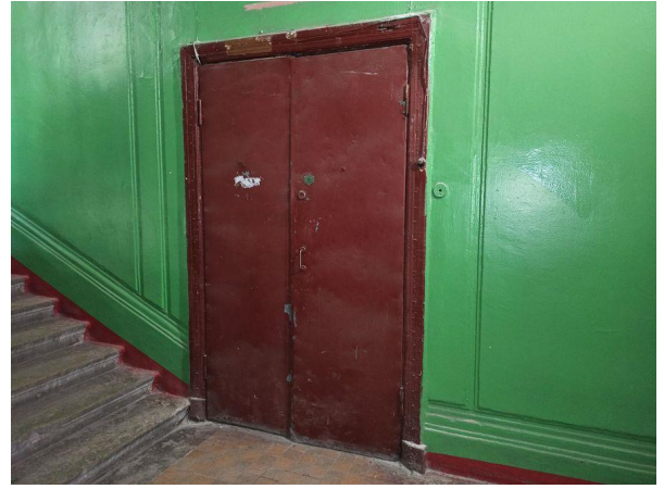
Фото 16. Вход 3 в помещение
