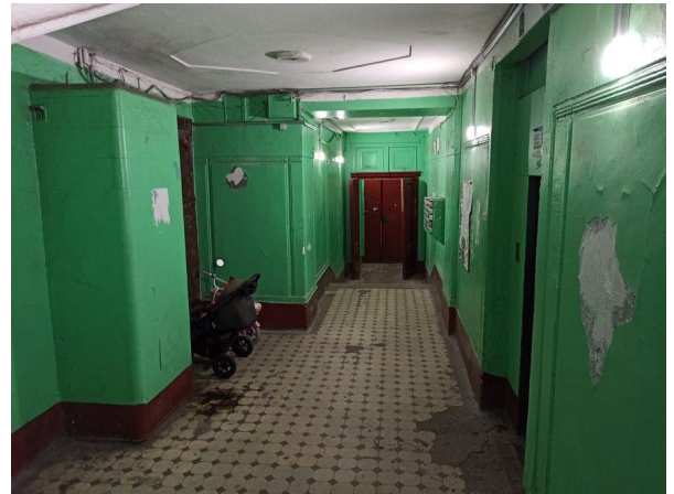
Фото 18. Доступ (вид ЛК)
