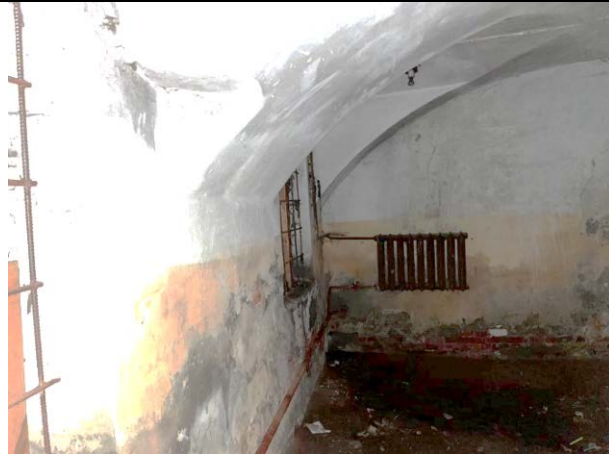
Фото 21. Типичное состояние Объекта оценки
