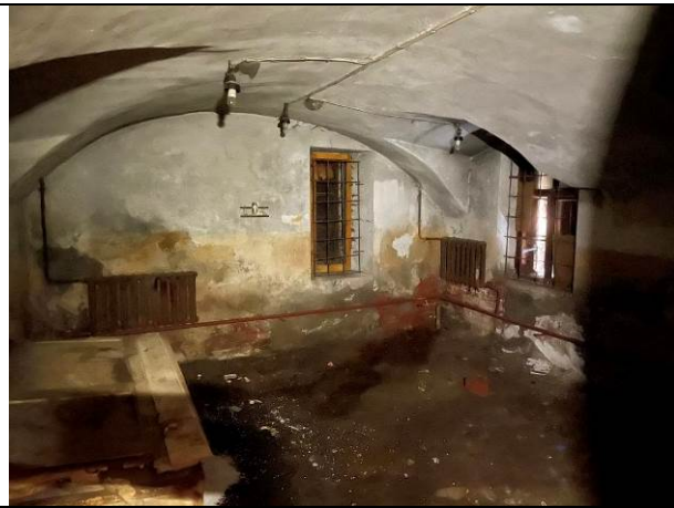
Фото 19. Типичное состояние Объекта оценки
