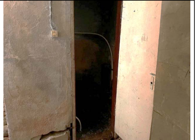
Фото 22. Типичное состояние Объекта оценки
