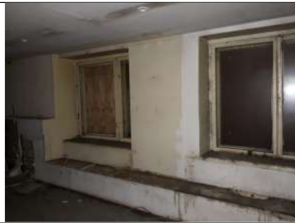
Фото 23. Внутреннее состояние Объекта оценки
