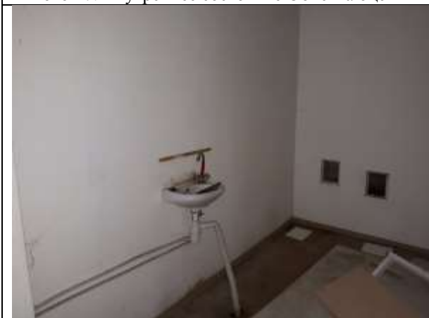
Фото 19. Внутреннее состояние Объекта оценки
