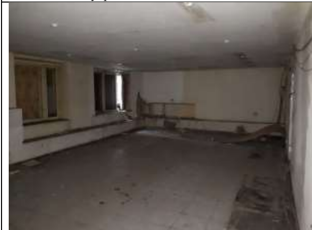
Фото 17. Внутреннее состояние Объекта оценки
