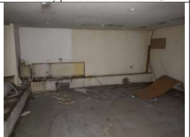
Фото 20. Внутреннее состояние Объекта оценки
