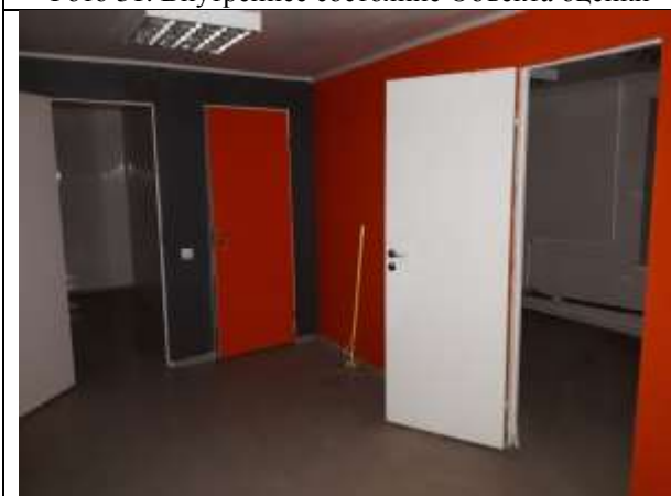
Фото 33. Внутреннее состояние Объекта оценки
