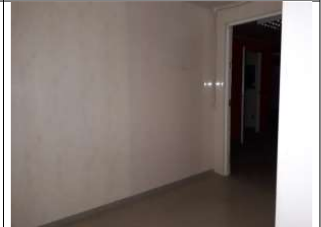
Фото 26. Внутреннее состояние Объекта оценки
