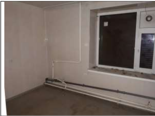
Фото 39. Внутреннее состояние Объекта оценки
