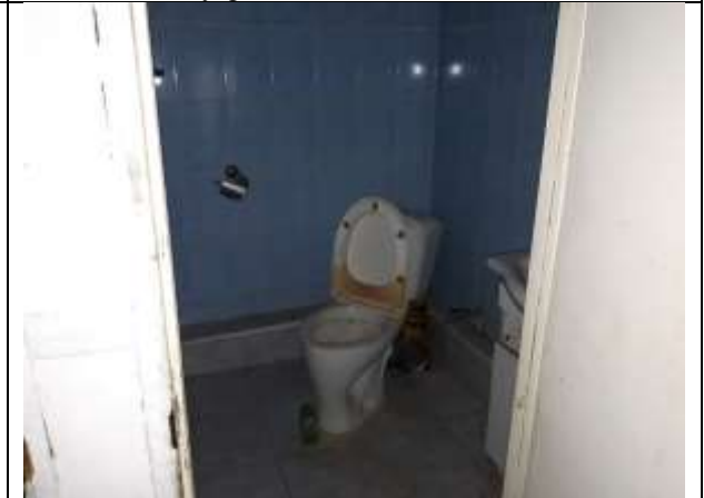
Фото 28. Внутреннее состояние Объекта оценки
