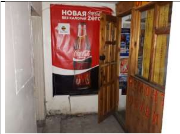
Фото 15. Внутреннее состояние Объекта оценки
