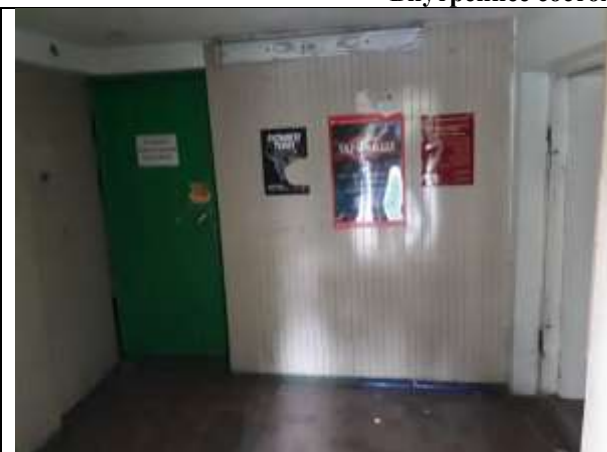
Фото 13. Внутреннее состояние Объекта оценки
