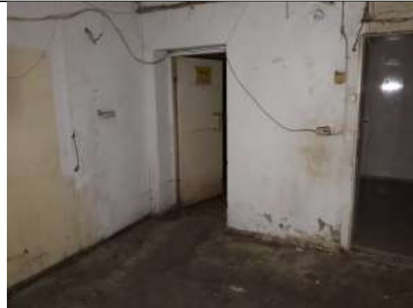
Фото 25. Внутреннее состояние Объекта оценки
