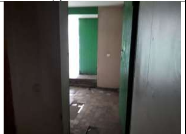
Фото 18. Внутреннее состояние Объекта оценки
