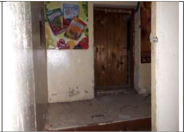
Фото 24. Внутреннее состояние Объекта оценки
