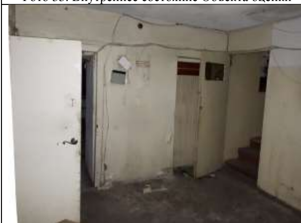
Фото 35. Внутреннее состояние Объекта оценки
