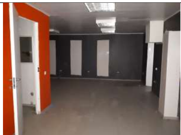
Фото 32. Внутреннее состояние Объекта оценки
