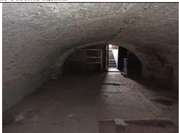
Фото 12. Внутреннее состояние Объекта оценки
