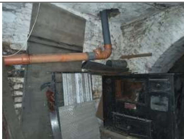
Фото 16. Внутреннее состояние Объекта оценки
