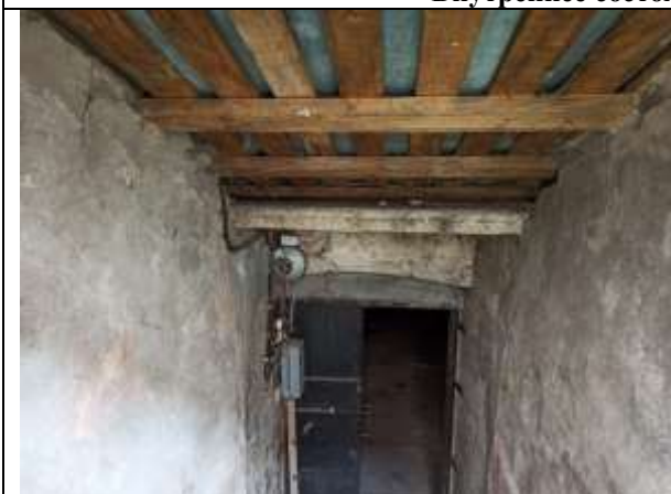
Фото 11. Внутреннее состояние Объекта оценки
