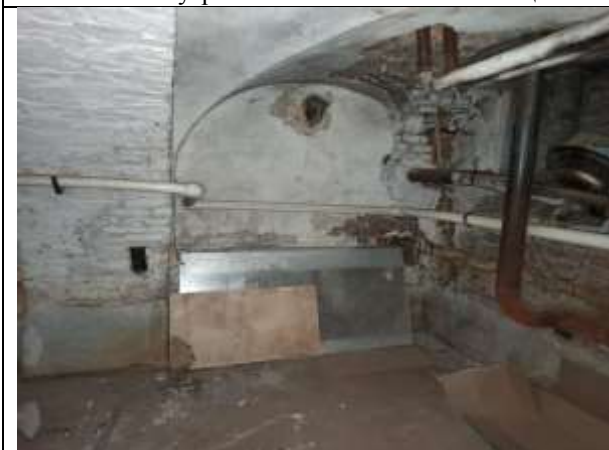
Фото 13. Внутреннее состояние Объекта оценки
