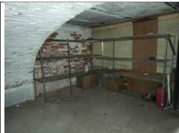
Фото 15. Внутреннее состояние Объекта оценки
