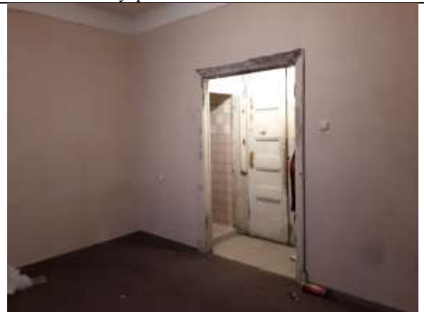
Фото 14. Внутреннее состояние Объекта оценки
