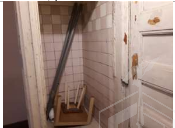
Фото 16. Внутреннее состояние Объекта оценки
