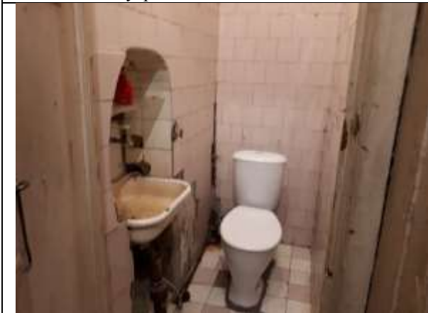
Фото 15. Внутреннее состояние Объекта оценки
