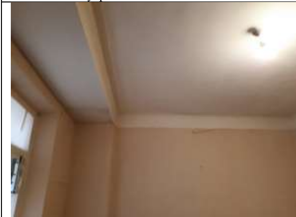
Фото 13. Внутреннее состояние Объекта оценки
