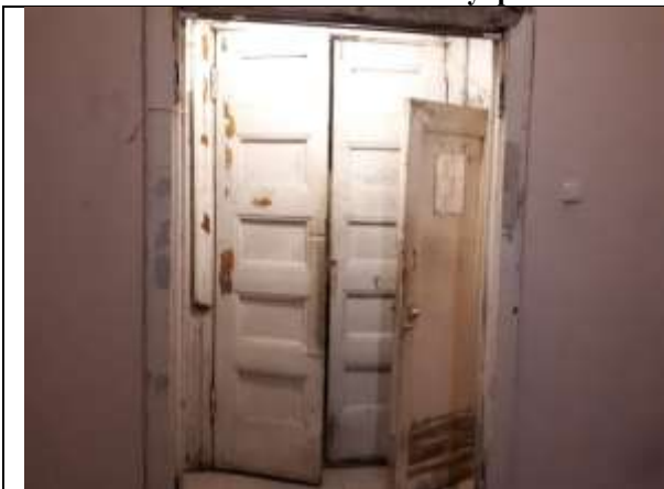
Фото 11. Внутреннее состояние Объекта оценки
