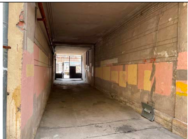
Фото 12. Проход через арку на внутри кварталную территорию здания расположения Объекта оценки
