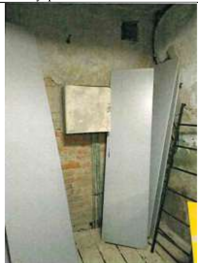
Фото 21. Внутреннее состояние Объекта оценки
