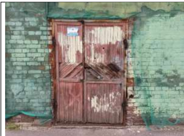
Фото 13. Общий вход со двора
