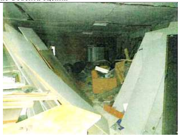
Фото 17. Внутреннее состояние Объекта оценки
