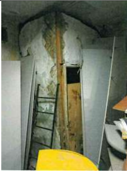
Фото 18. Внутреннее состояние Объекта оценки
