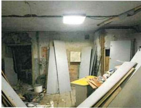
Фото 20. Внутреннее состояние Объекта оценки
