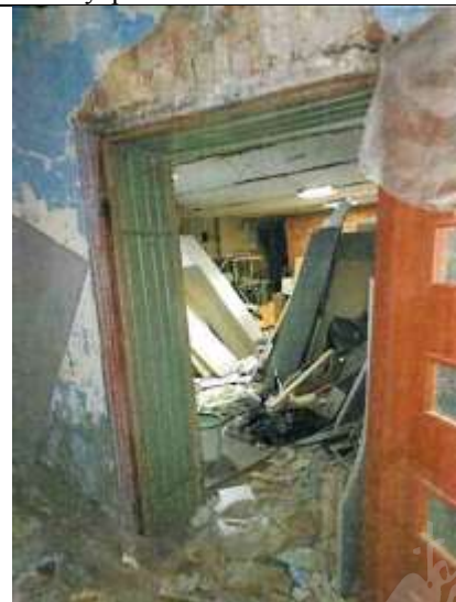
Фото 23. Проход из пом. 6-Н (ч.п.3) в пом. 7-Н (ч.п.1)
