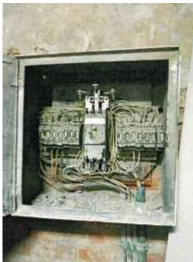
Фото 22. Внутреннее состояние Объекта оценки
