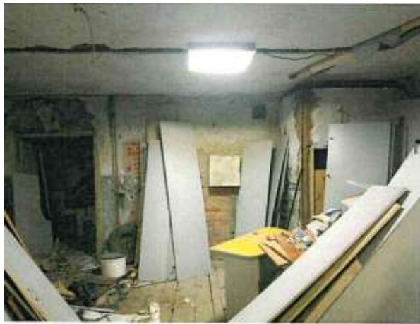
Фото 20. Внутреннее состояние Объекта оценки
