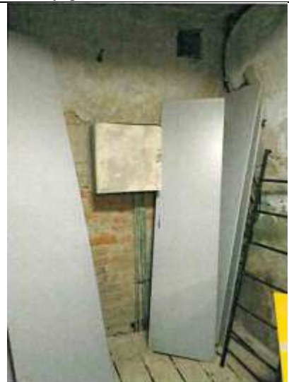
Фото 21. Внутреннее состояние Объекта оценки
