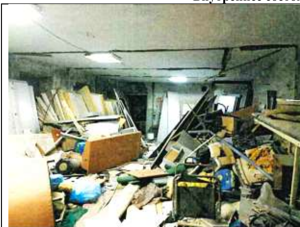
Фото 16. Внутреннее состояние Объекта оценки
