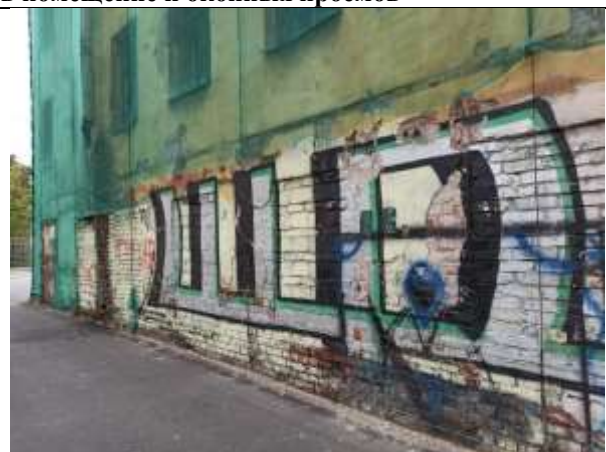
Фото 12. Общий вход со двора и окна (заложены кирпичом)
