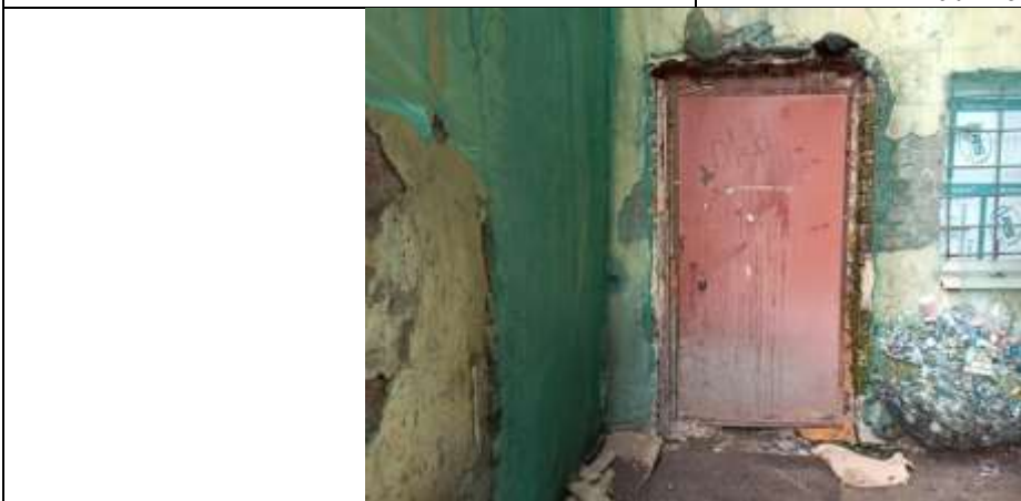
Фото 15. Общий вход в соседнее пом. 7-Н Внутреннее состояние Объекта оценки
