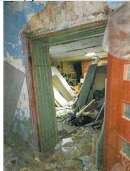
Фото 23. Проход из пом. 6-Н (ч.п.3) в пом. 7-Н (ч.п.1)
