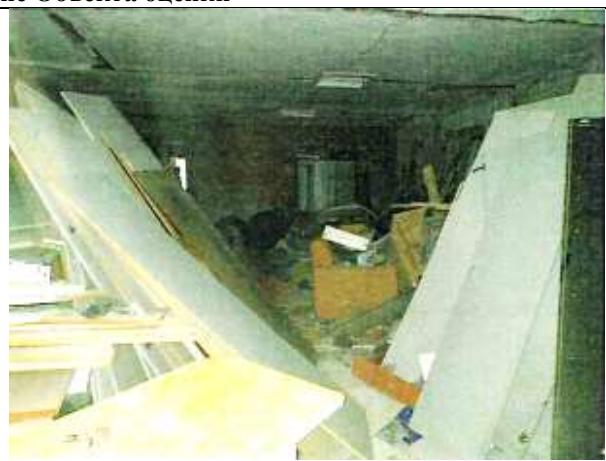
Фото 17. Внутреннее состояние Объекта оценки
