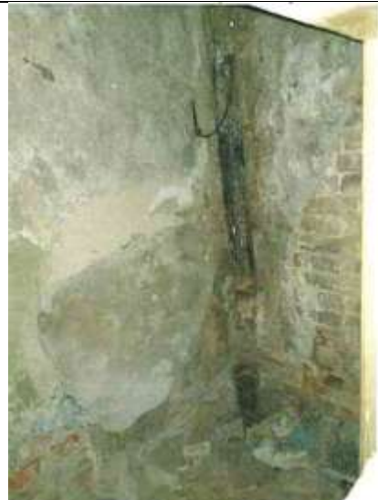
Фото 19. Внутреннее состояние Объекта оценки
