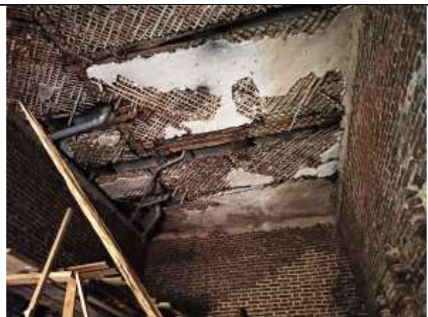
Фото 14. Внутреннее состояние Объекта оценки
