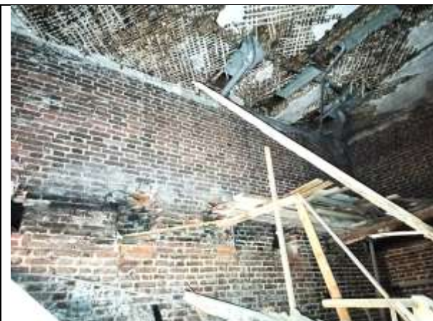
Фото 13. Внутреннее состояние Объекта оценки
