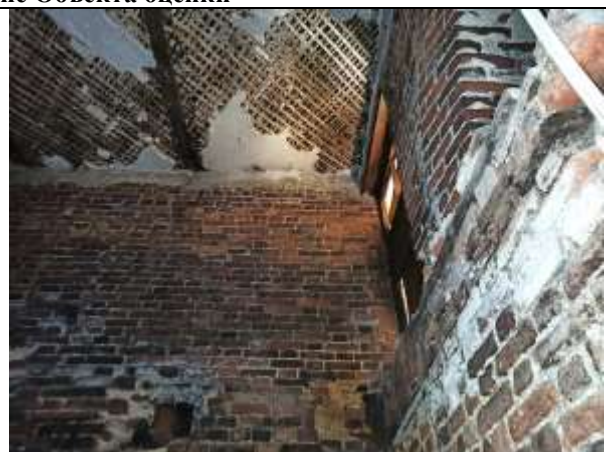
Фото 12. Внутреннее состояние Объекта оценки
