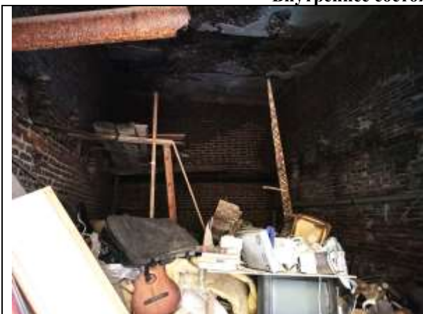
Фото 11. Внутреннее состояние Объекта оценки
