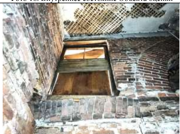
Фото 18. Внутреннее состояние Объекта оценки
