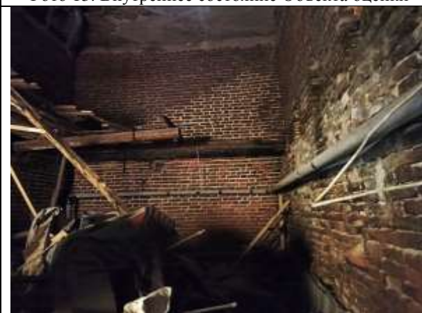
Фото 15. Внутреннее состояние Объекта оценки
