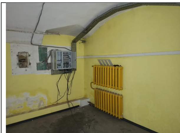
Фото 37. Внутреннее состояние Объекта оценки
