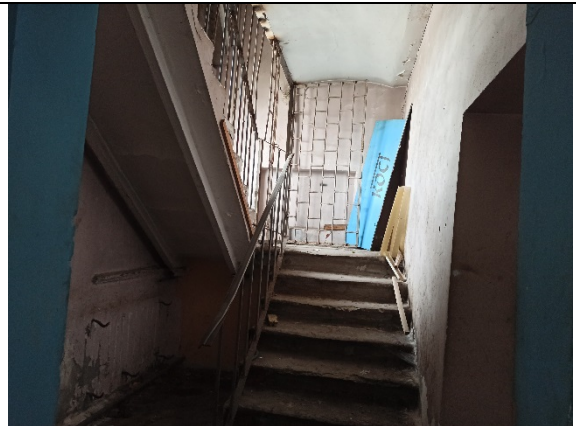
Помещение 43-Н лестница на 2 этаж
