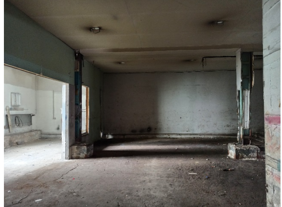
Помещение 43-Н 1 этаж
