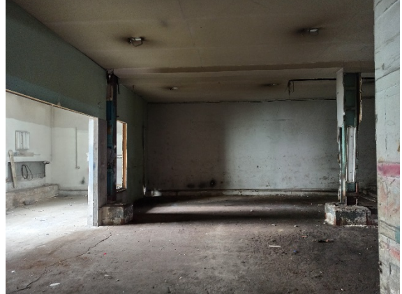
Помещение 43-Н 1 этаж
