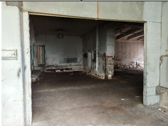
Помещение 43-Н 1 этаж
