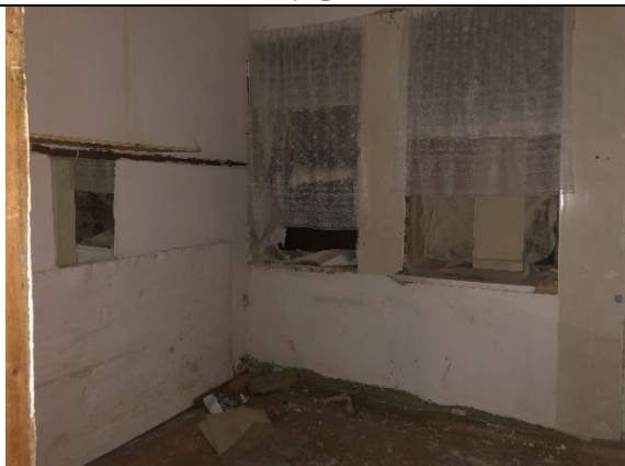
Фото № 33 – Внутреннее состояние
