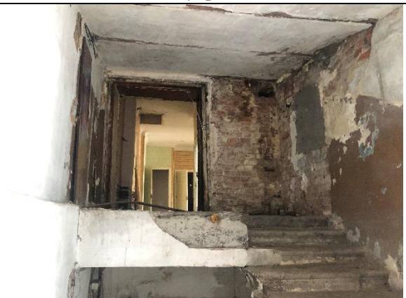
Фото № 10 - Внутренне состояние
