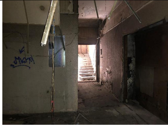
Фото № 38 – Внутреннее состояние
