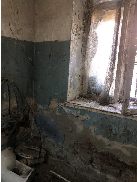
Фото № 35 – Внутреннее состояние
