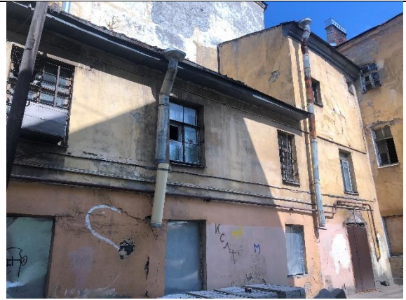
Фото № 42 – Фасад здания
