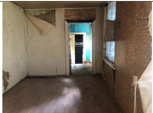
Фото № 6 - Внутренне состояние
