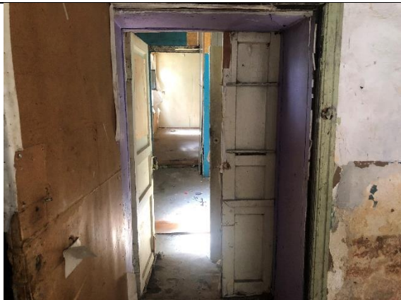
Фото № 3 – Внутреннее состояние
