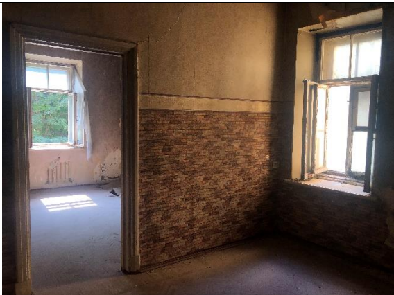
Фото № 27 - Внутреннее состояние
