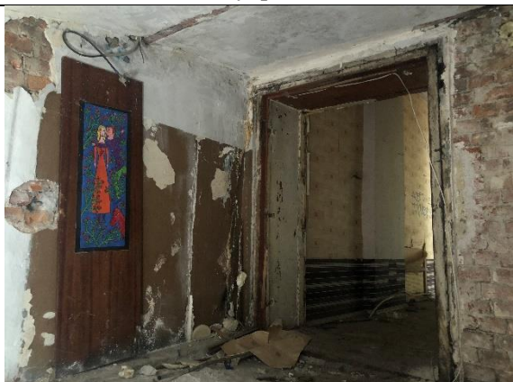
Фото № 11 - Внутреннее состояние
