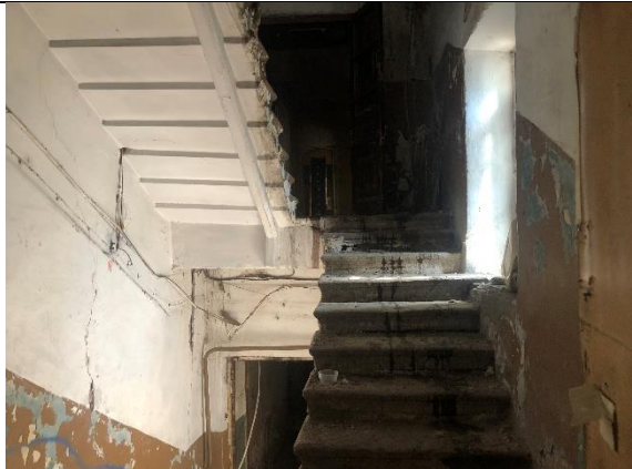
Фото № 7 - Внутренне состояние
