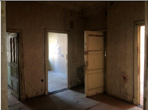
Фото № 25 - Внутреннее состояние
