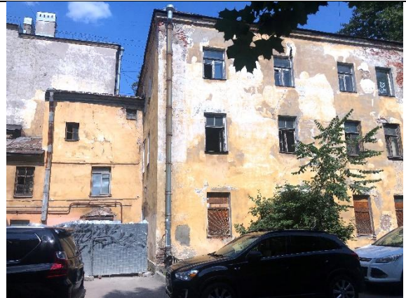
Фото № 44 – Фасад здания
