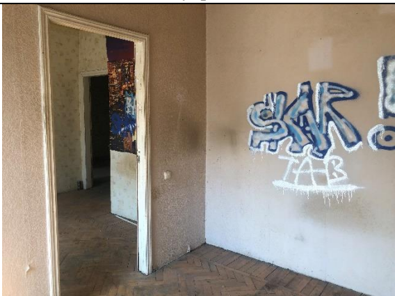
Фото № 17 - Внутреннее состояние
