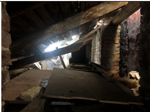
Фото № 9 - Внутренне состояние
