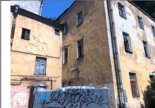
Фото № 43 – Фасад здания
