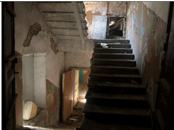
Фото № 29 – Внутреннее состояние
