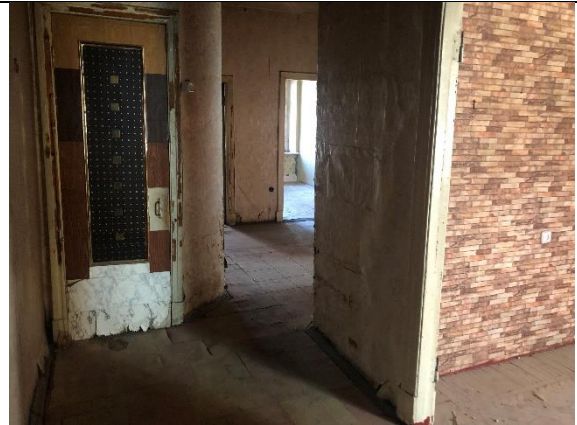
Фото № 24 - Внутреннее состояние
