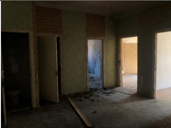
Фото № 13 - Внутреннее состояние
