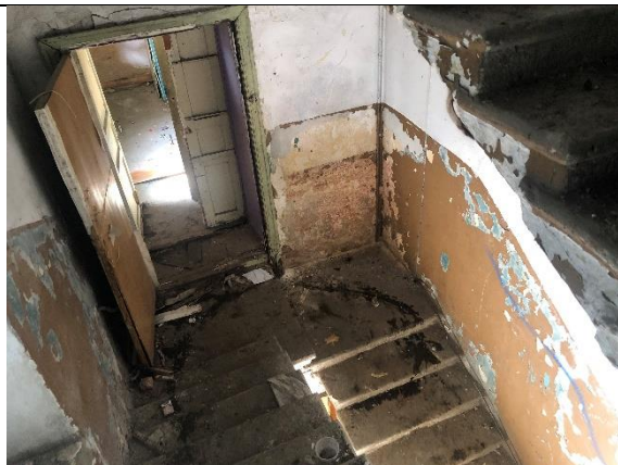
Фото № 30 – Внутреннее состояние
