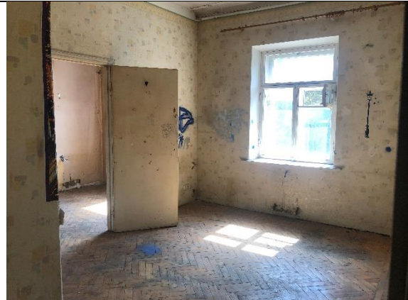
Фото № 16 - Внутреннее состояние
