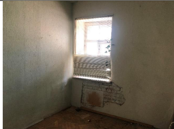
Фото № 14 - Внутреннее состояние
