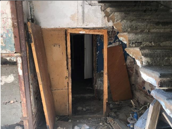
Фото № 39 – Внутреннее состояние
