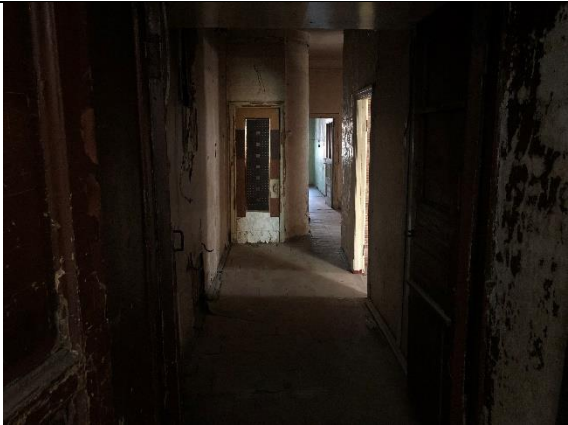
Фото № 23 - Внутреннее состояние
