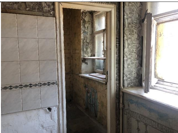
Фото № 19 - Внутреннее состояние
