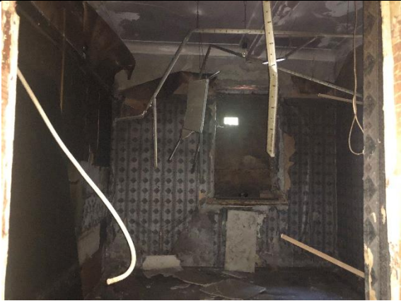
Фото № 37 – Внутреннее состояние
