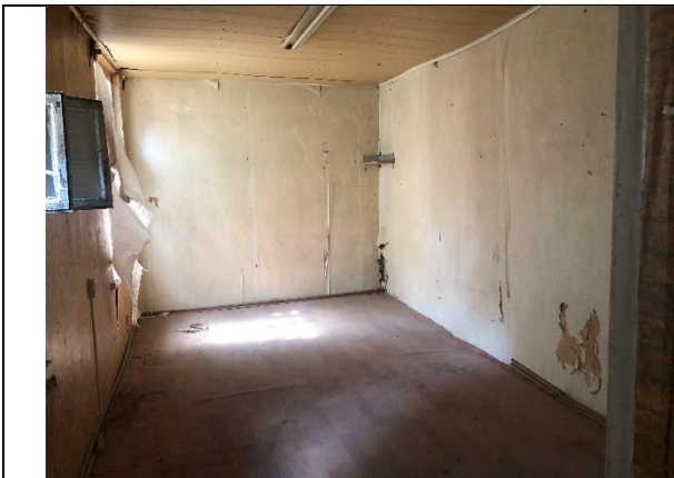
Фото № 5 – Внутреннее состояние
