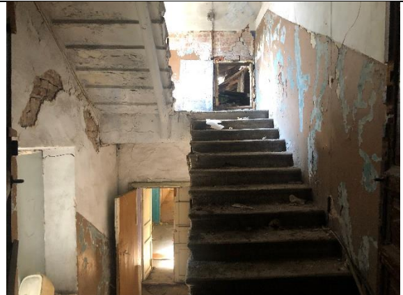
Фото № 8 - Внутренне состояние
