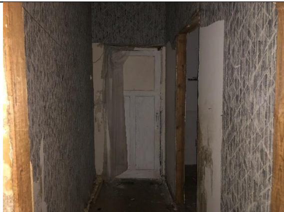
Фото № 32 – Внутреннее состояние
