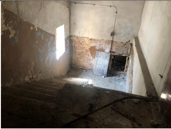
Фото № 21 - Внутреннее состояние
