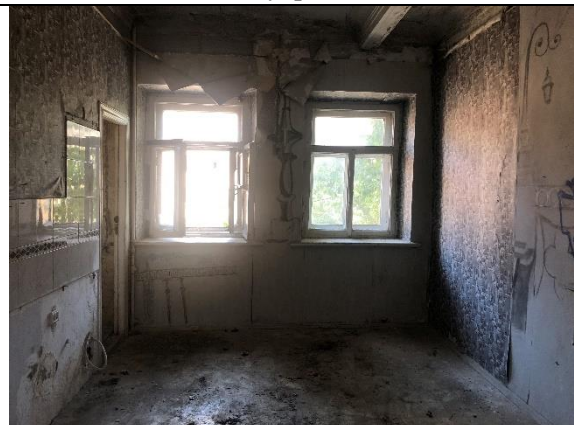
Фото № 18 - Внутреннее состояние
