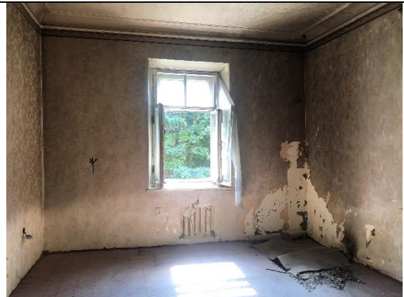
Фото № 26 - Внутреннее состояние
