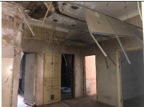
Фото № 34 – Внутреннее состояние
