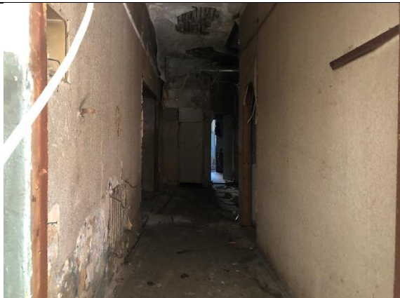
Фото № 31 – Внутреннее состояние
