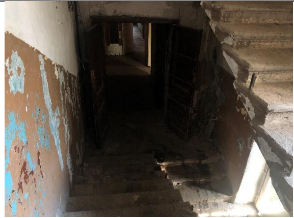
Фото № 22 - Внутреннее состояние
