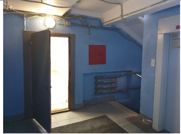
Фото № 26 - Внутреннее состояние
