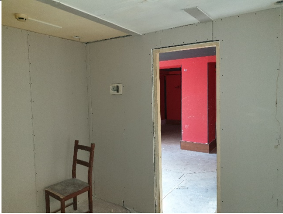
Фото № 17 - Внутреннее состояние
