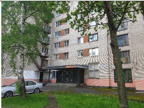
Фото № 29 - Фасад здания
