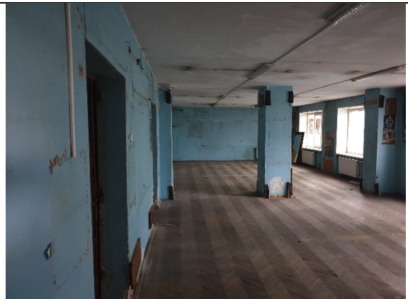
Фото № 22 - Внутреннее состояние
