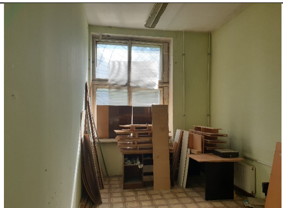
Фото № 14 - Внутреннее состояние
