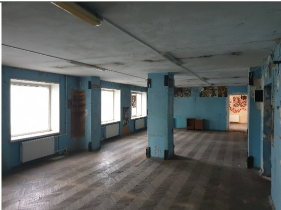
Фото № 23 - Внутреннее состояние
