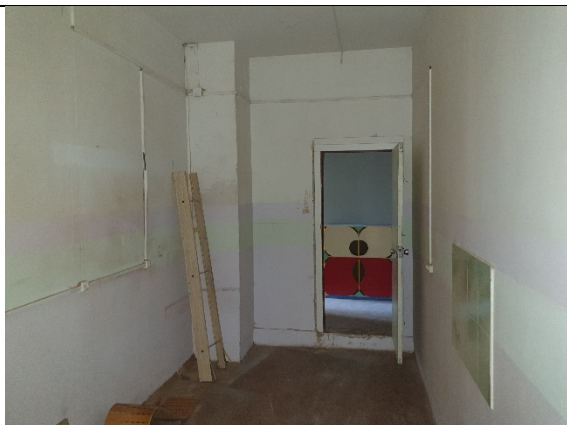
Фото № 13 - Внутреннее состояние
