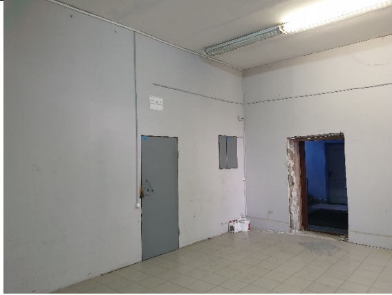
Фото № 25 - Внутреннее состояние
