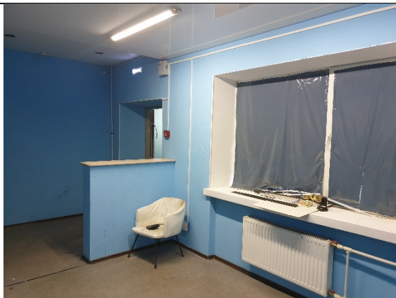
Фото № 3 – Внутреннее состояние
