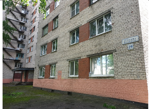
Фото № 28 – Фасад здания
