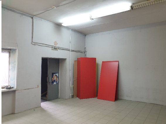
Фото № 27 - Внутреннее состояние
