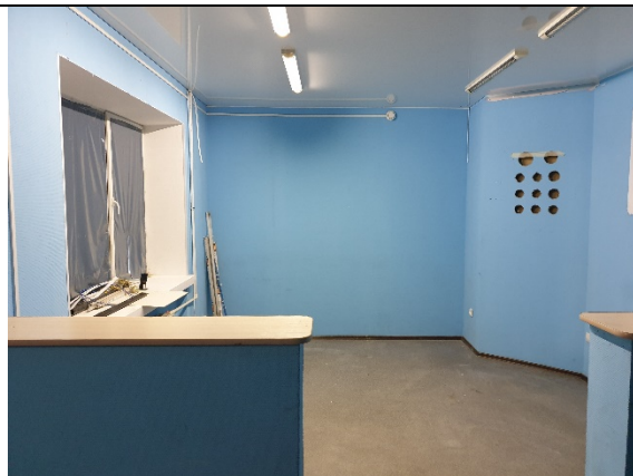
Фото № 2 – Внутреннее состояние
