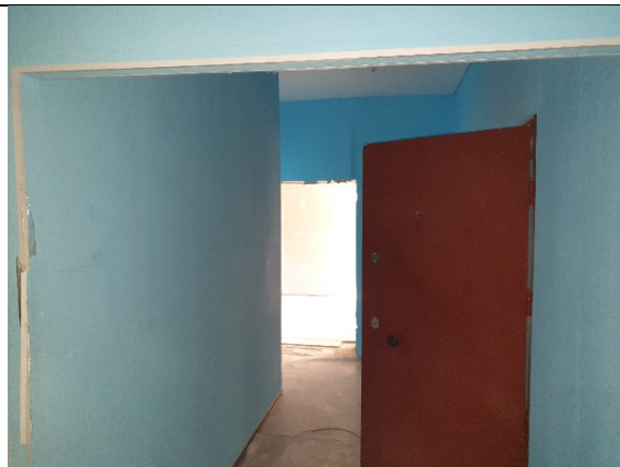
Фото № 4 – Внутреннее состояние
