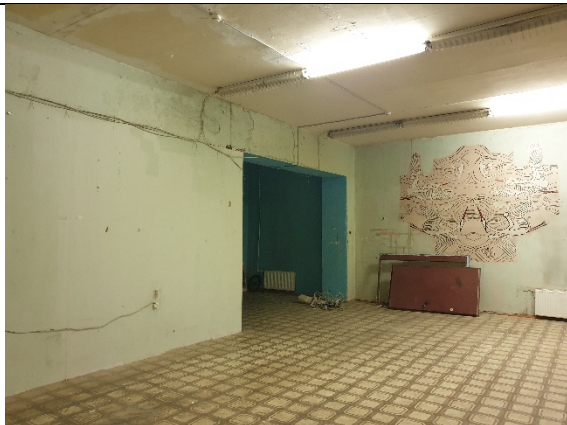
Фото № 11 - Внутреннее состояние
