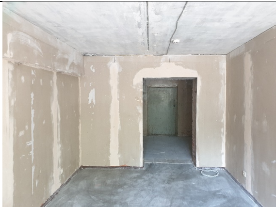
Фото № 7 - Внутренне состояние
