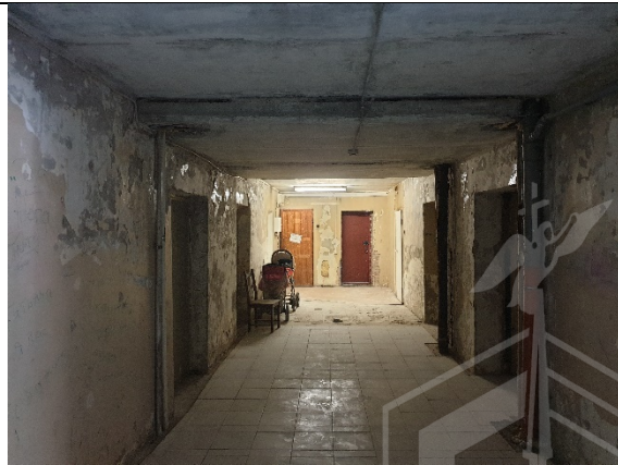
Фото № 8 - Внутренне состояние
