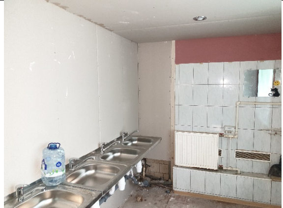
Фото № 20 - Внутреннее состояние
