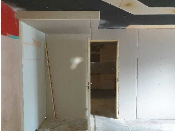
Фото № 19 - Внутреннее состояние
