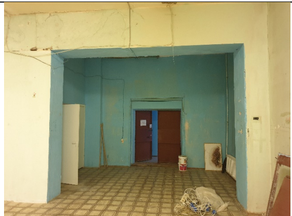
Фото № 12 - Внутреннее состояние
