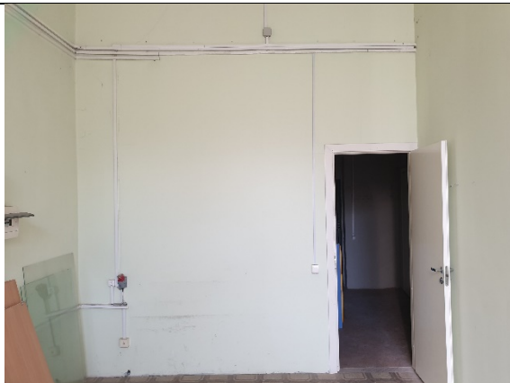
Фото № 15 - Внутреннее состояние
