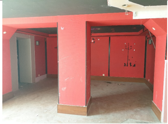
Фото № 18 - Внутреннее состояние
