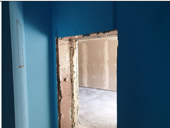
Фото № 5 – Внутреннее состояние
