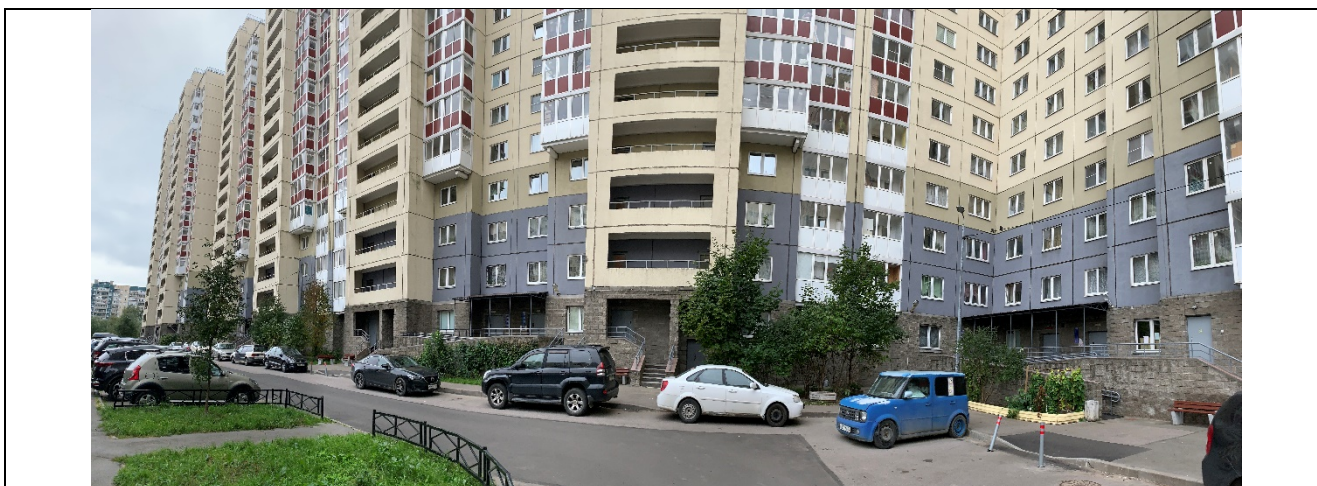
Фото №1 Жилой дом, в котором располагается Объект оценки
