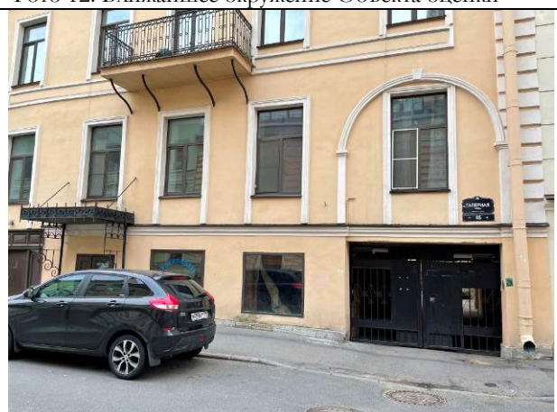
Фото 14. Вид здания Объекта оценки
