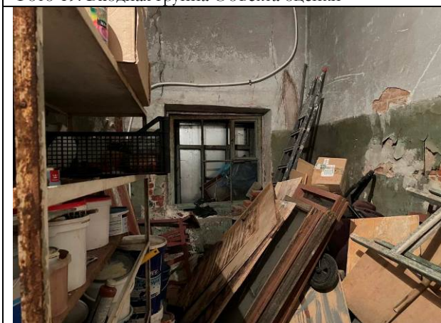
Фото 21. Типичное состояние Объекта оценки
