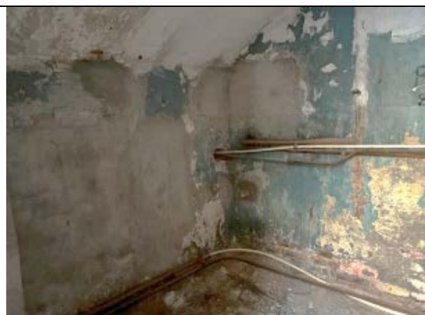
Фото 32. Типичное состояние Объекта оценки
