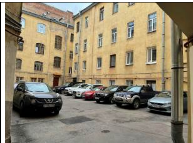
Фото 27. Внутри дворовая территория Объекта оценки
