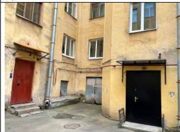
Фото 29. Внутри дворовая территория Объекта оценки
