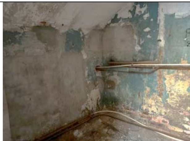
Фото 32. Типичное состояние Объекта оценки
