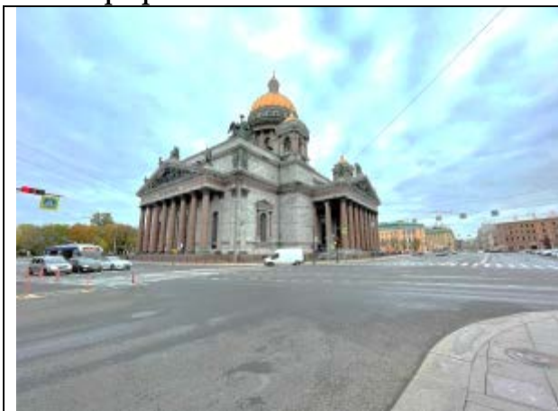
Фото 1. Ближайшее окружение Объекта оценки (Исаакиевская площадь)
