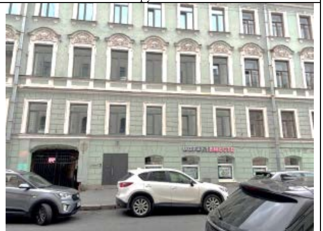
Фото 24. Вид здания Объекта оценки
