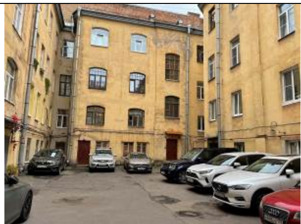
Фото 28. Внутри дворовая территория Объекта оценки
